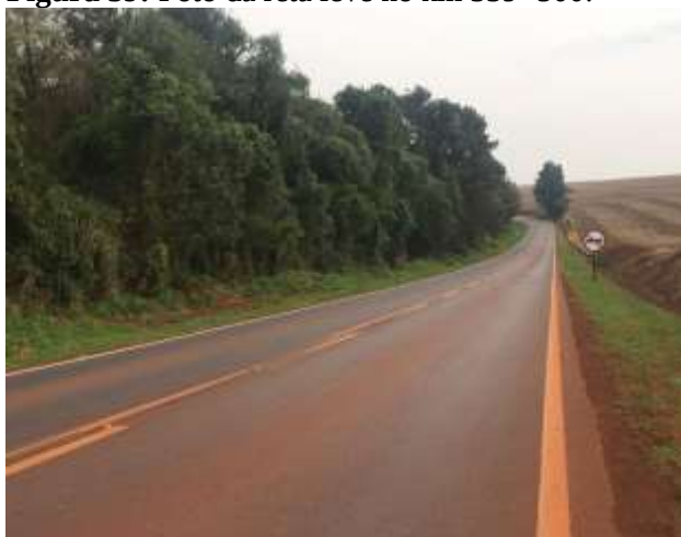
Figura 39: Foto da reta leve no km 339+500.
