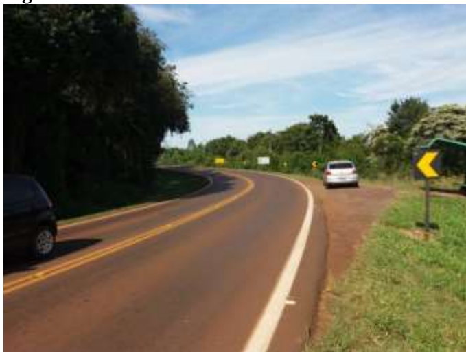
Figura 31: Foto da curva acentuada no km 335+500.
