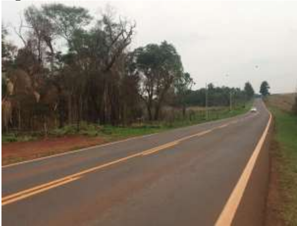
Figura 41: Foto da reta no km 340+500.
