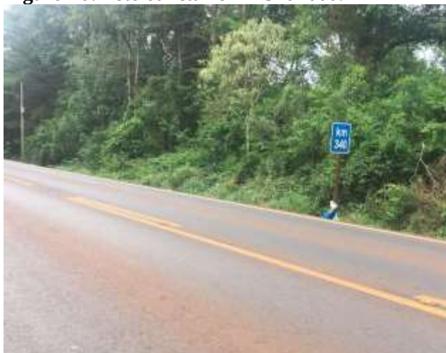
Figura 40: Foto da reta no km 340+000.
