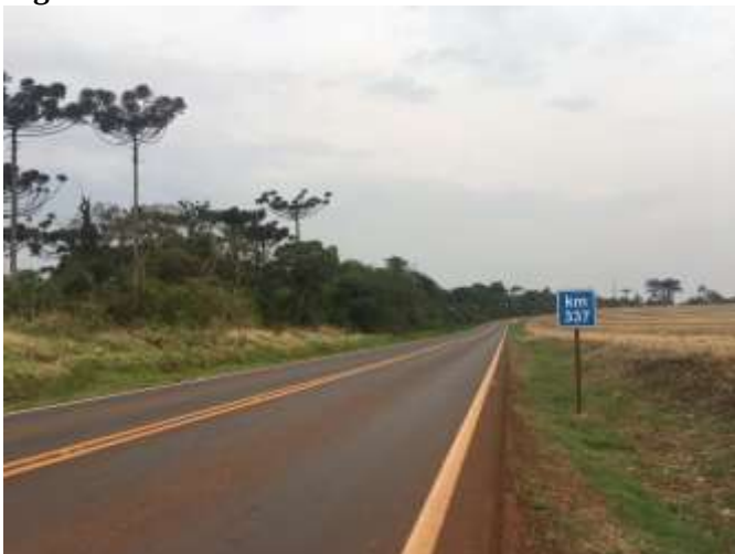
Figura 34: Foto da reta no km 337+000.
