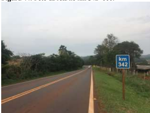
Figura 44: Foto da reta no km 342+000.
