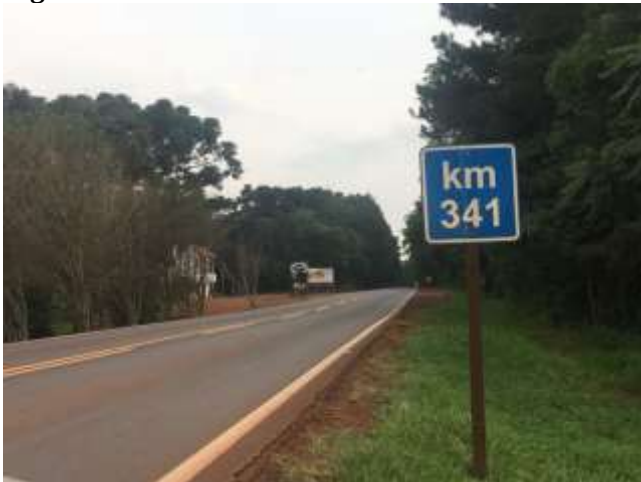
Figura 42: Foto da reta no km 341+000.
