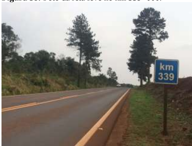
Figura 38: Foto da reta leve no km 339+000.
