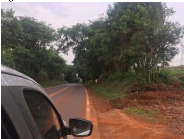
Figura 43: Foto da reta no km 341+500.
