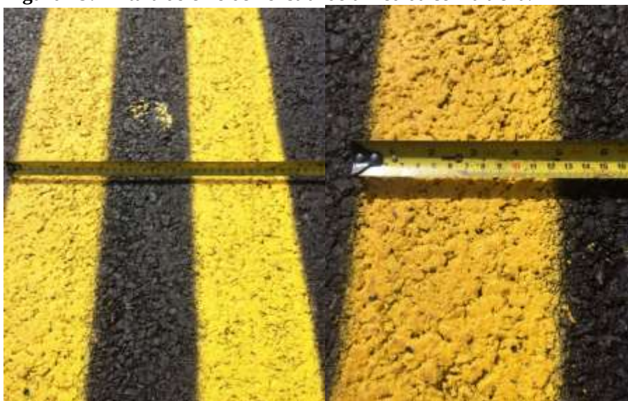
Figura 49: Pintura do eixo demonstrando a medida com a trena.
