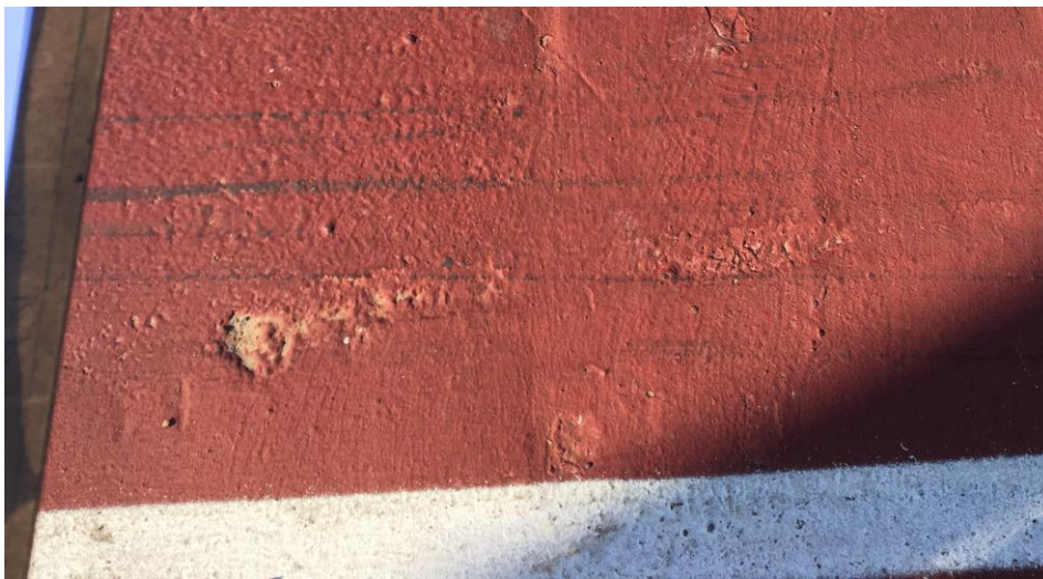
Figura 15: Painéis no Pavimento:
