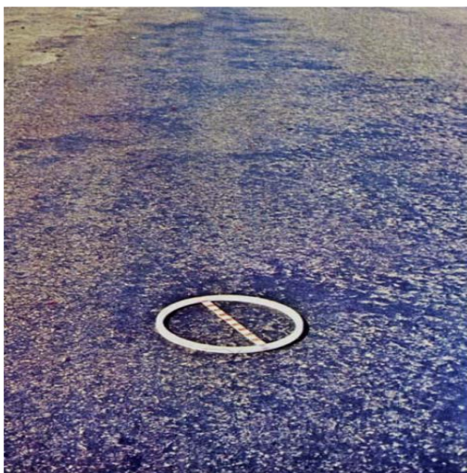
Figura 8: Demonstração de exsudação:
