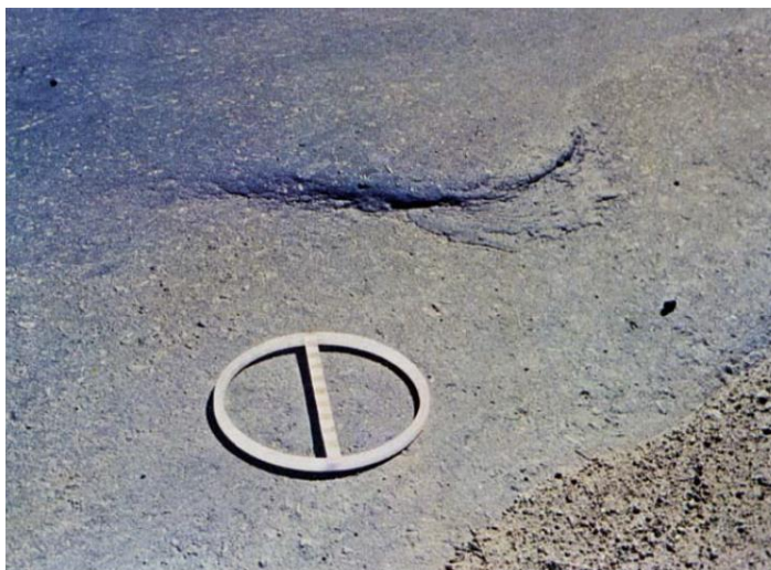
Figura 7: Demonstração de um escorregamento:
