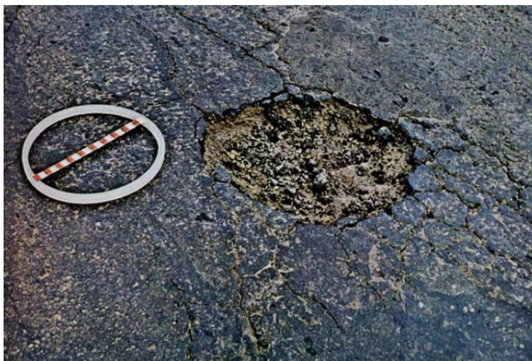
Figura 10: Demonstração de panela:
