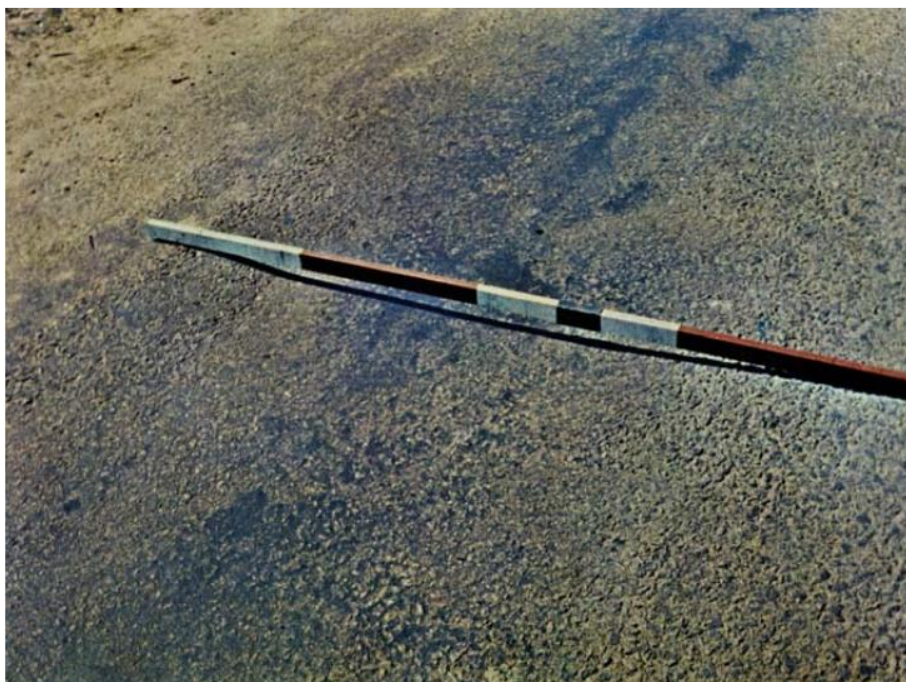
Figura 6: Coleta de afundamento local:
