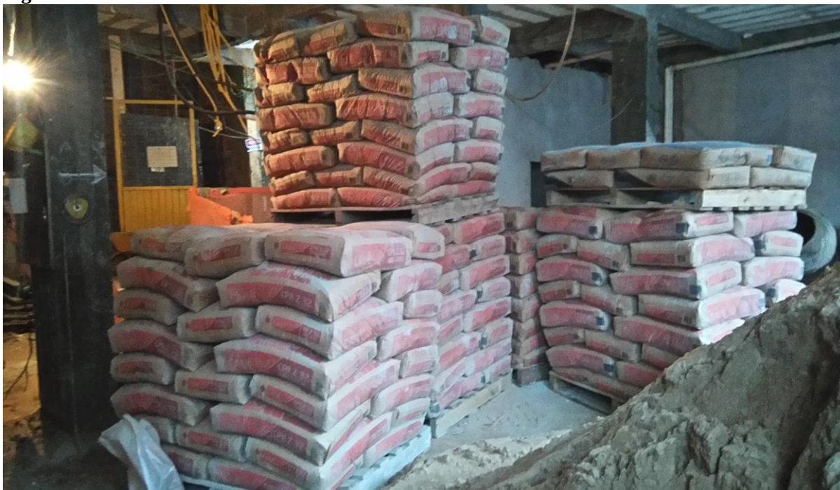
Figura 26: Armazenamento dos sacos de cimento.
