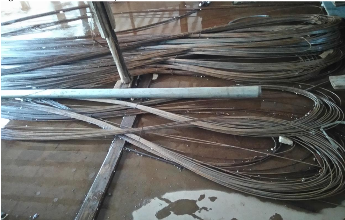
Figura 23: Armazenamento do aço.
