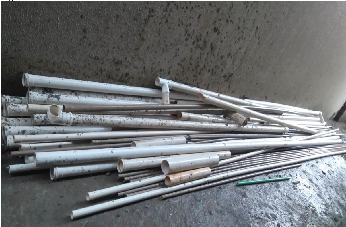
Figura 24: Armazenamento dos tubos de PVC.
