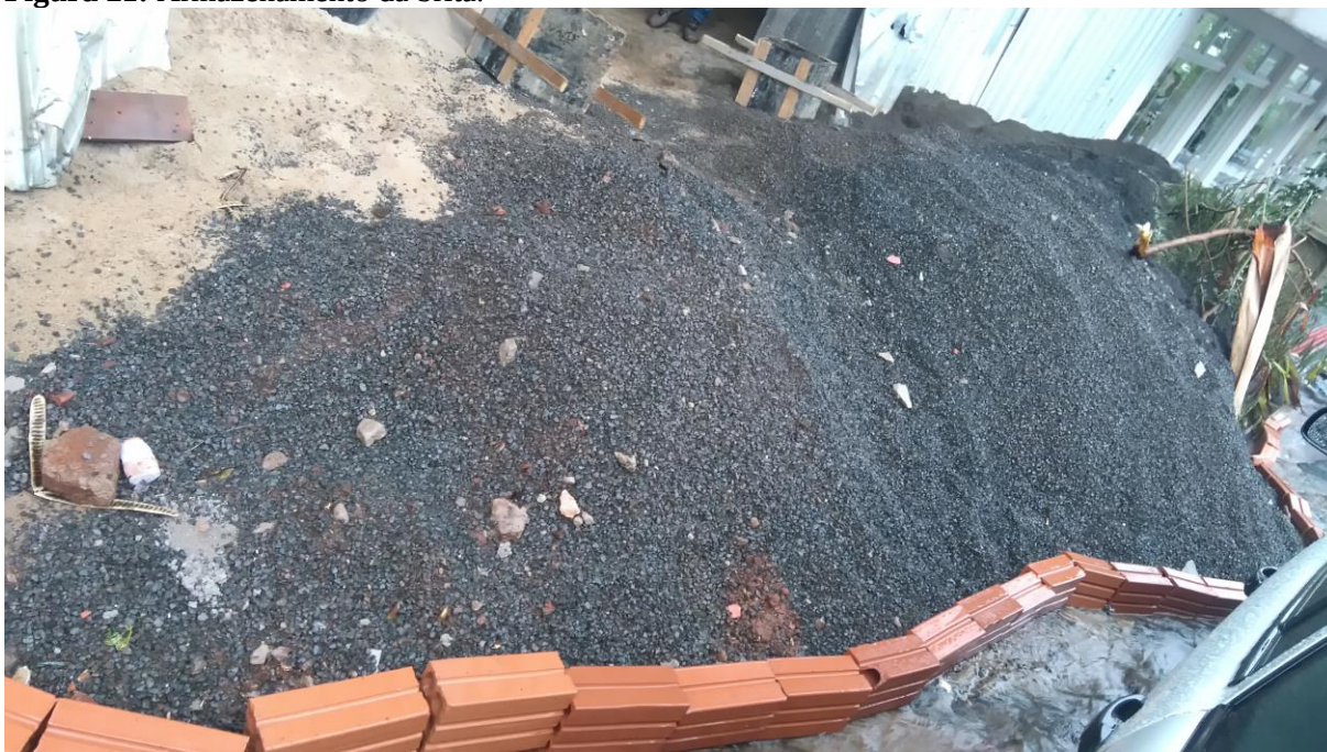
Figura 21: Armazenamento da brita.
