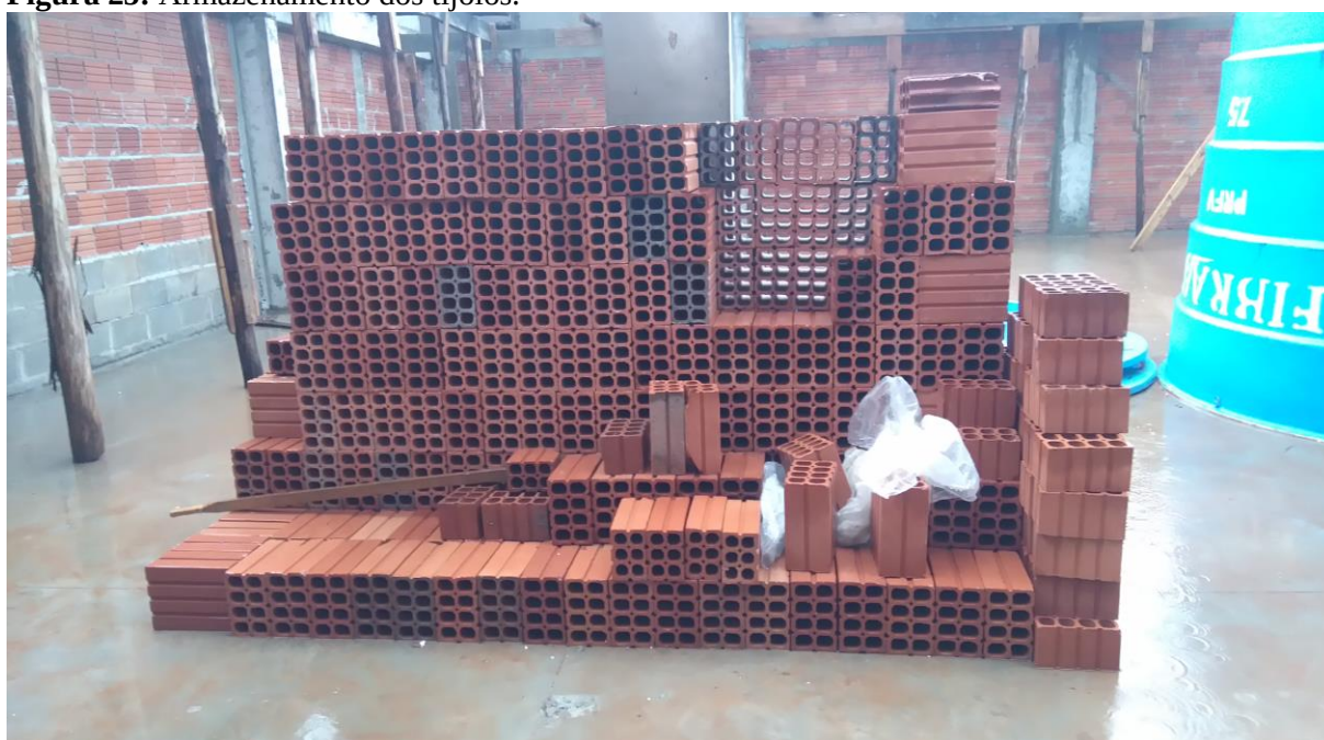
Figura 25: Armazenamento dos tijolos.
