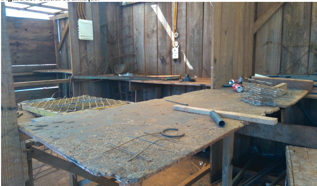
Figura 28: Central de armação.
