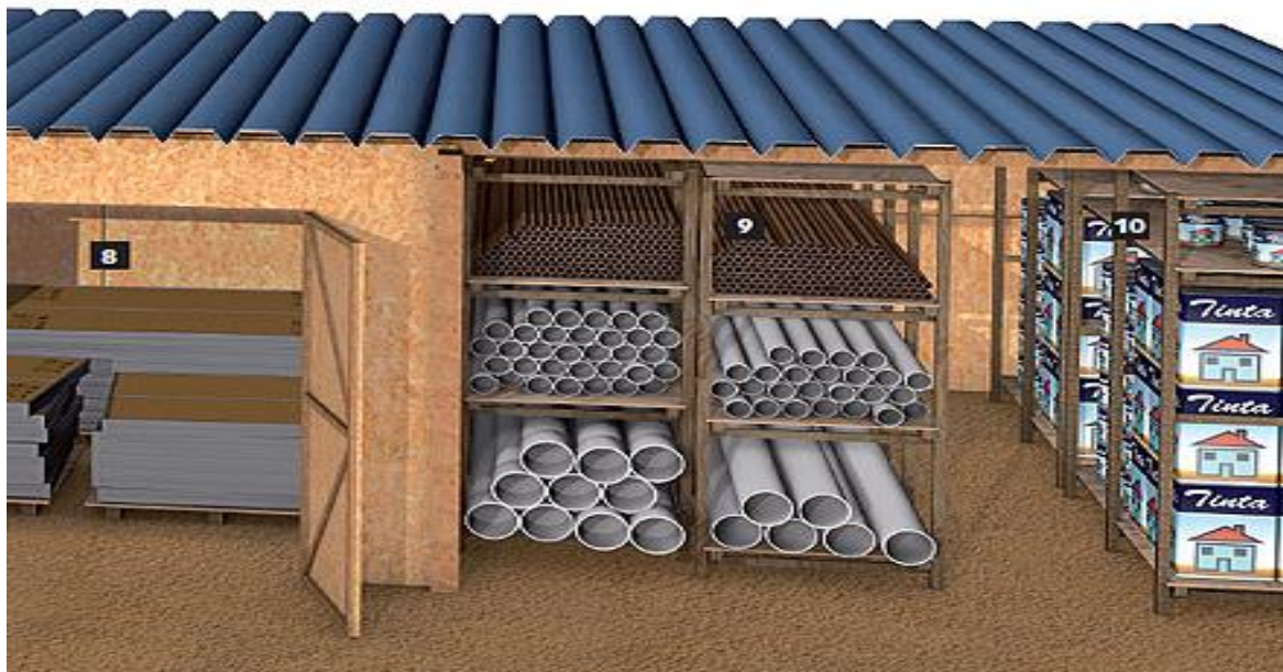
Figura 08: Exemplo de armazenamento dos tubos de PVC.
