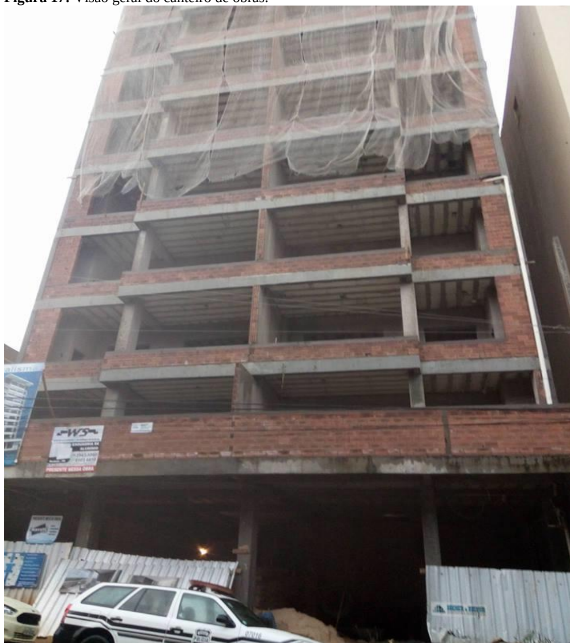
Figura 17: Visão geral do canteiro de obras.
