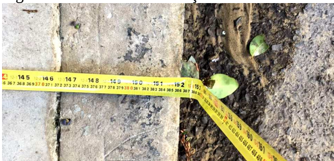
Figura 13 – Dimensão da calçada da Rua Dom Pedro II
