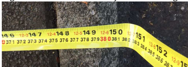
Figura 08 – Dimensão da calçada da Rua Engenheiro Rebouças
