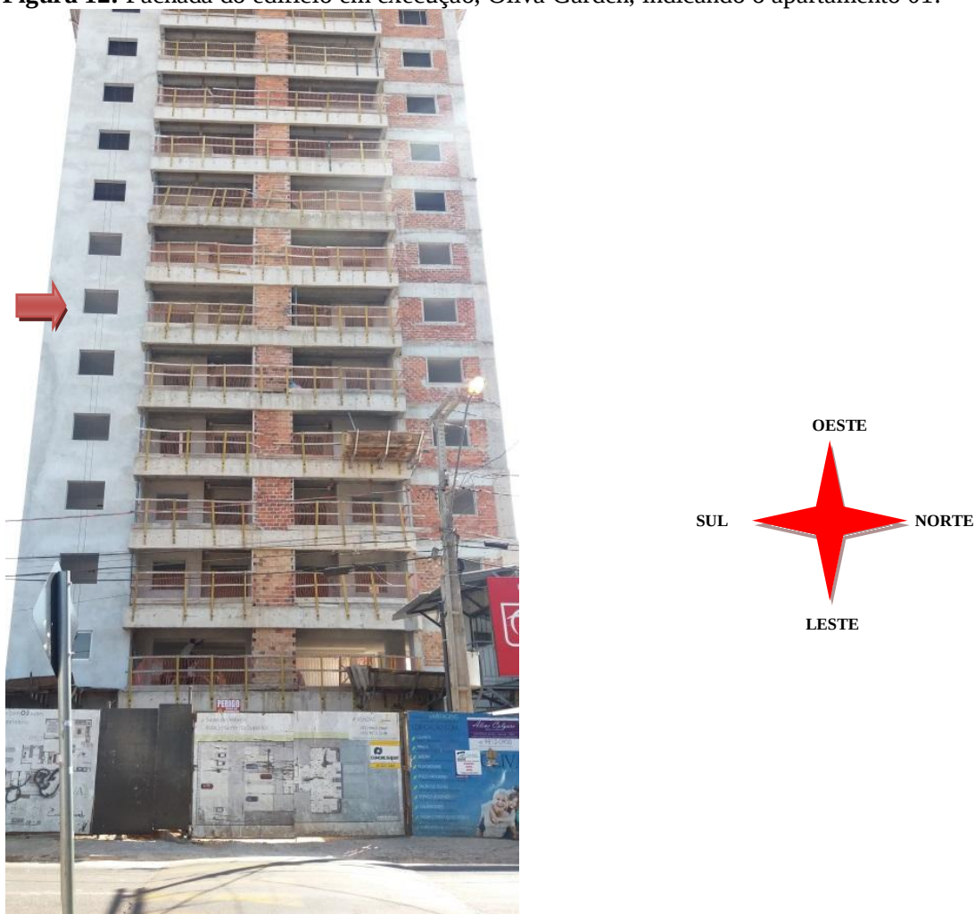
Figura 12: Fachada do edifício em execução, Oliva Garden, indicando o apartamento 01.
