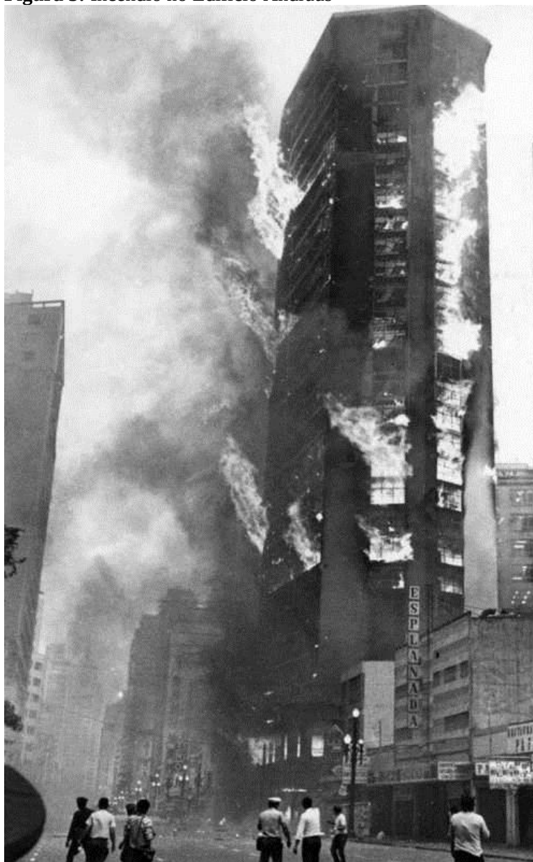
Figura 3: Incêndio no Edifício Andraus
