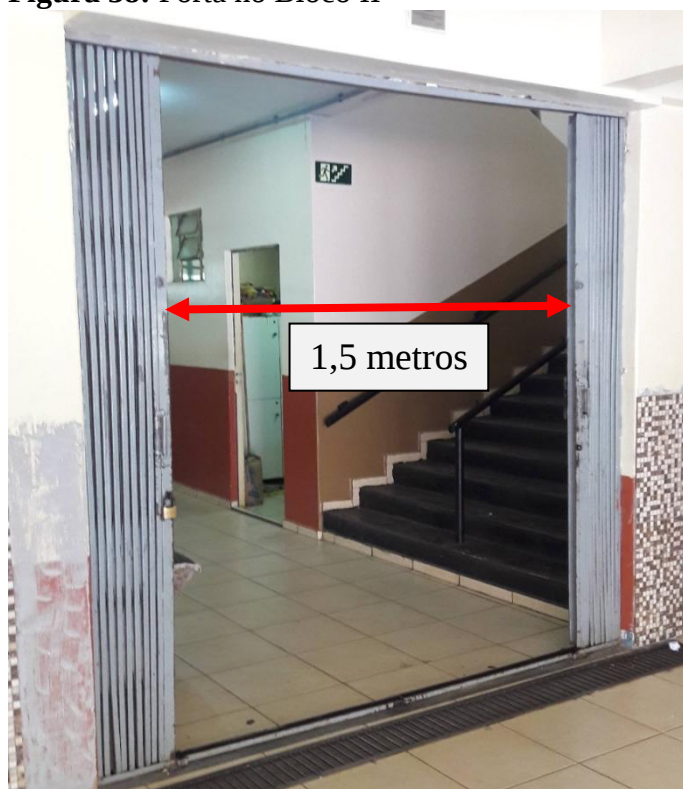
Figura 38: Porta no Bloco II
