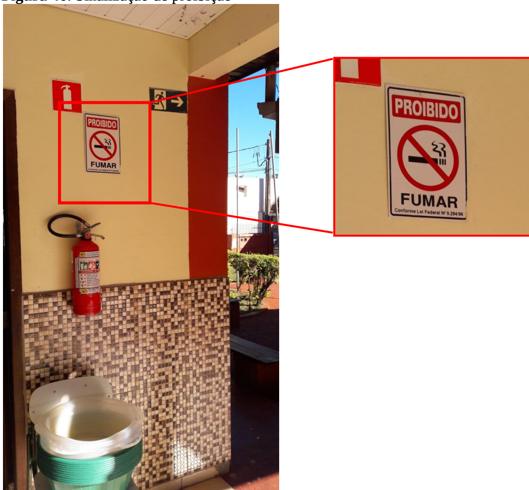
Figura 46: Sinalização de proibição
