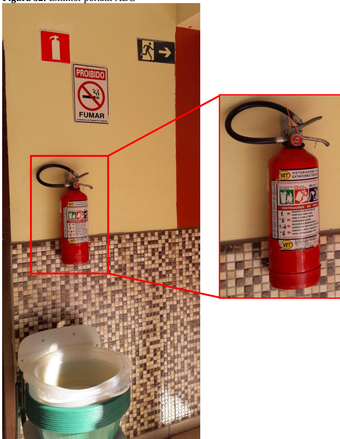
Figura 52: Extintor portátil ABC
