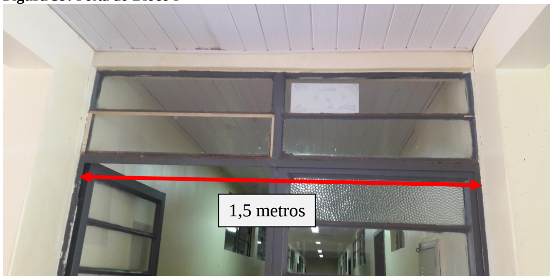
Figura 39: Porta do Bloco I
