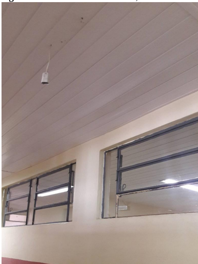
Figura 24: Corredor e sala de aula, Bloco I
