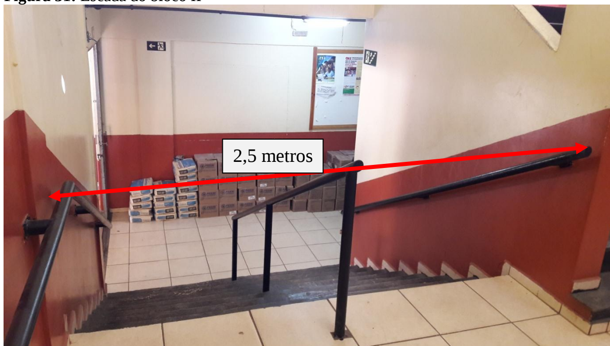
Figura 31: Escada do bloco II
