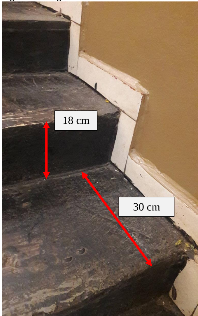
Figura 32: Degrau da escada do bloco II
