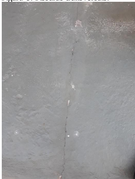
Figura 9: Fissuras transversais.
