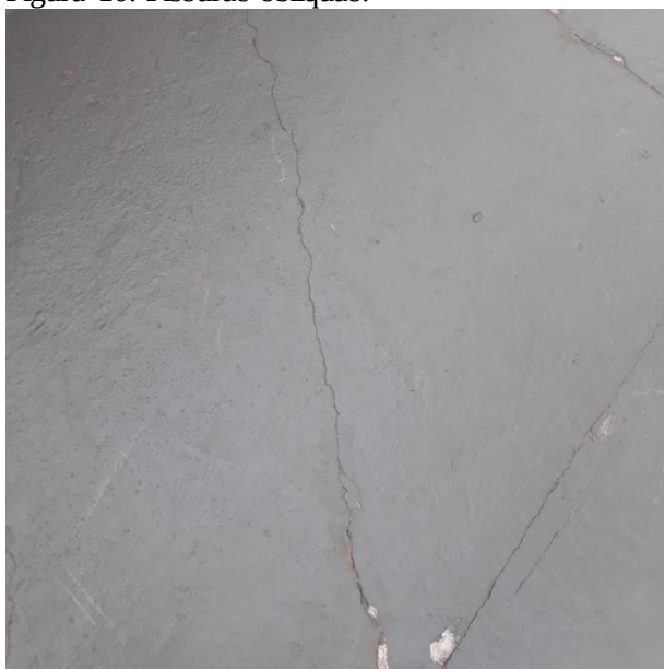
Figura 10: Fissuras oblíquas.
