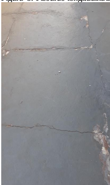
Figura 8: Fissuras longitudinais.
