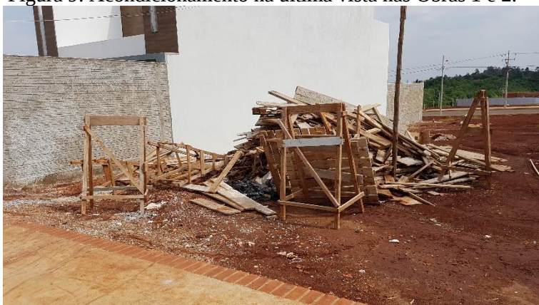
Figura 9: Acondicionamento na última vista nas Obras 1 e 2.
