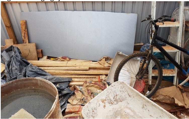
Figura 13: Segregação dos resíduos Obra 4.
