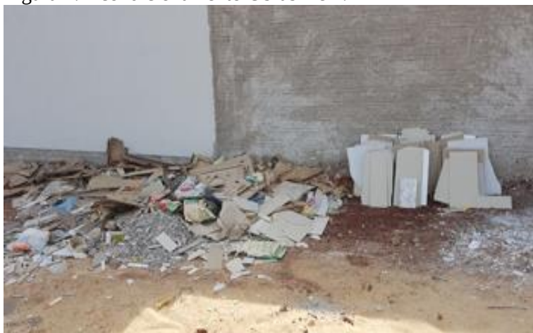
Figura 7: Acondicionamento Obras 1 e 2.
