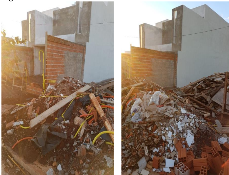
Figura 8: Acondicionamento Obras 1 e 2.
