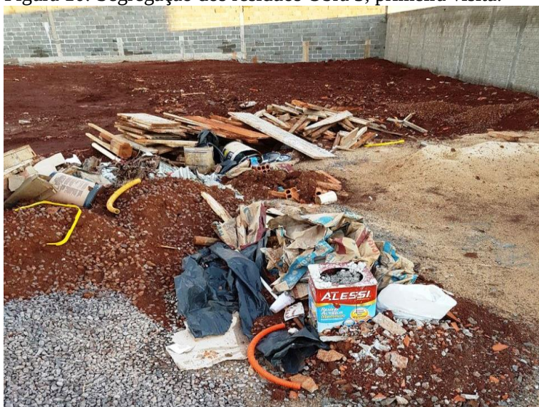
Figura 10: Segregação dos resíduos Obra 3, primeira visita.
