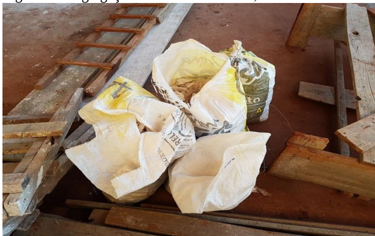
Figura 11: Segregação dos resíduos Obra 3, terceira visita.
