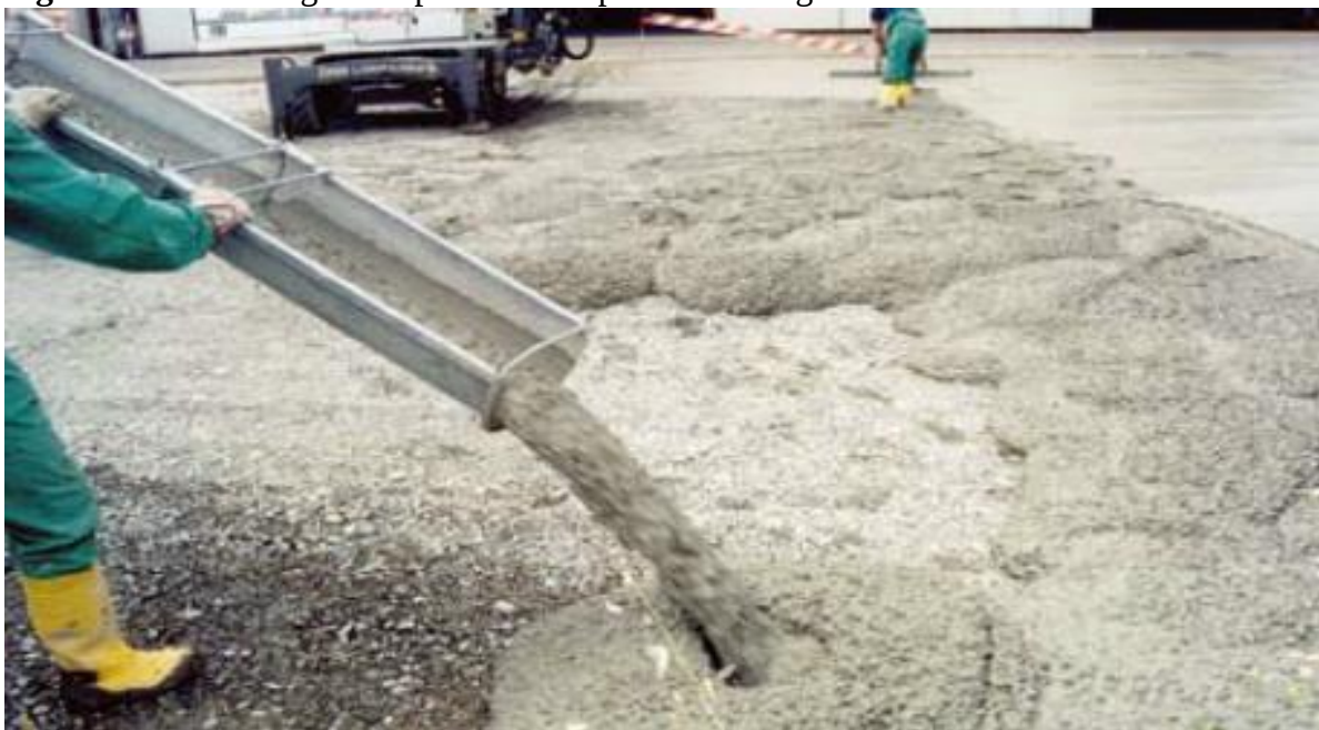
Figura 01: Concretagem do piso do Aeroporto em Boligna
