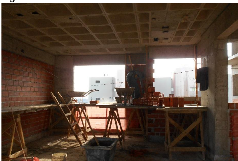
Figura 09: Andaime realizado sobre cavaletes.
