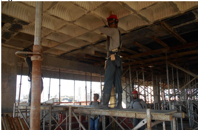
Figura 08: Andaime feito com escoras.
