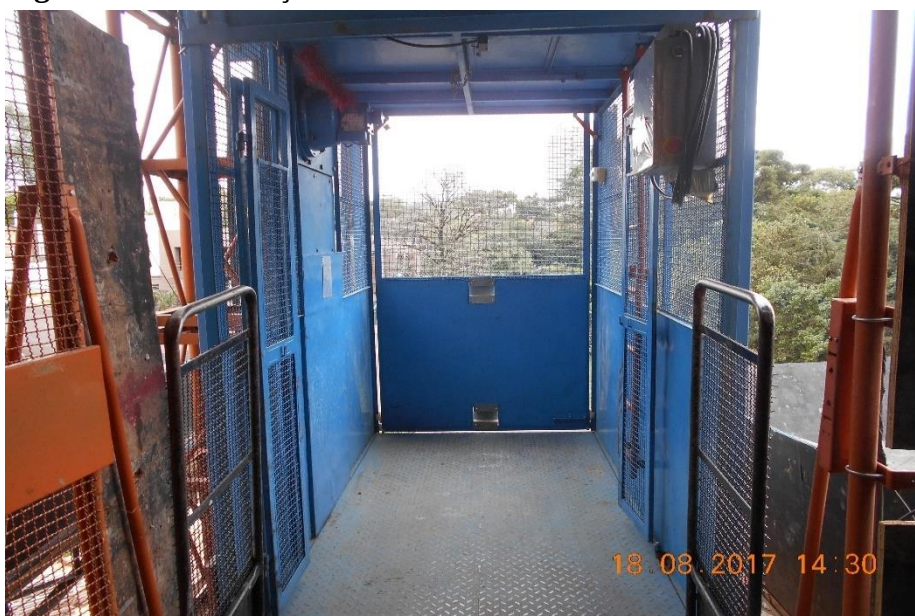
Figura 15: Conservação interna do elevador.
