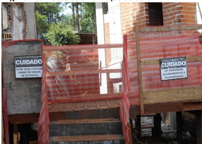
Figura 28: Placas de sinalização da obra.
