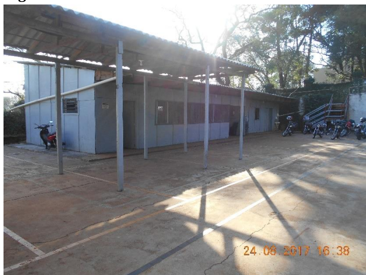
Figura 34: Área de vivência da obra.
