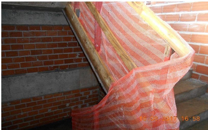
Figura 22: Guarda-corpo em escada.
