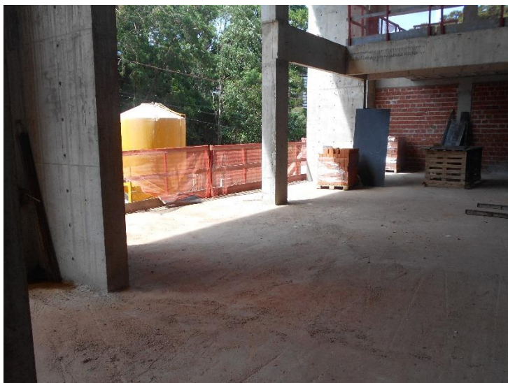
Figura 27: Detalhe da organização e limpeza do pavimento.
