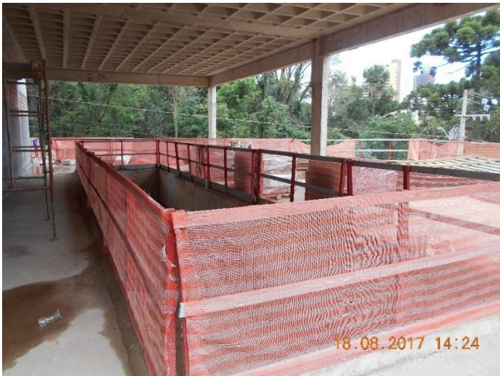
Figura 19: Proteção em periferia da piscina.
