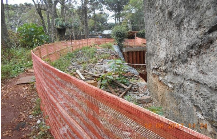
Figura 18: Proteção com guarda-corpo e local de talude.
