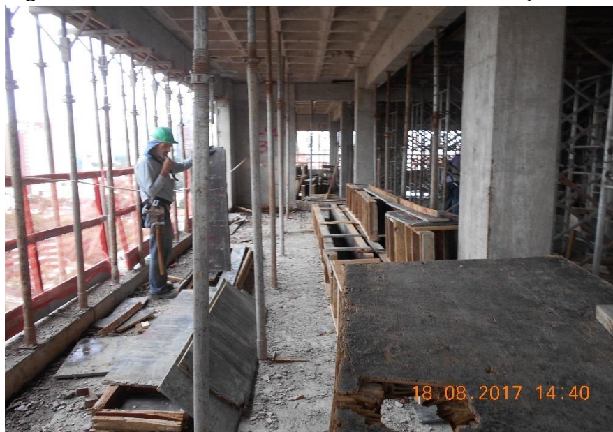
Figura 07: Detalhe da desforma sendo realizada no 10º pavimento
