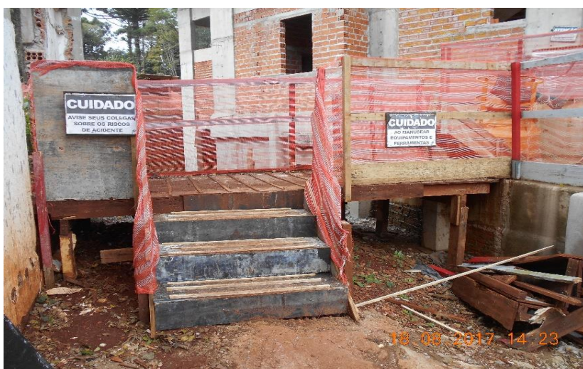
Figura 23: Escada de acesso a obra.
