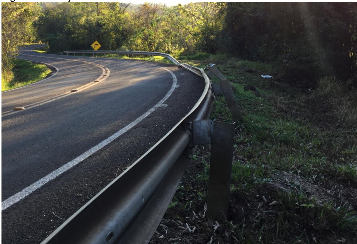
Figura 16: Proteção da rodovia danificada.
