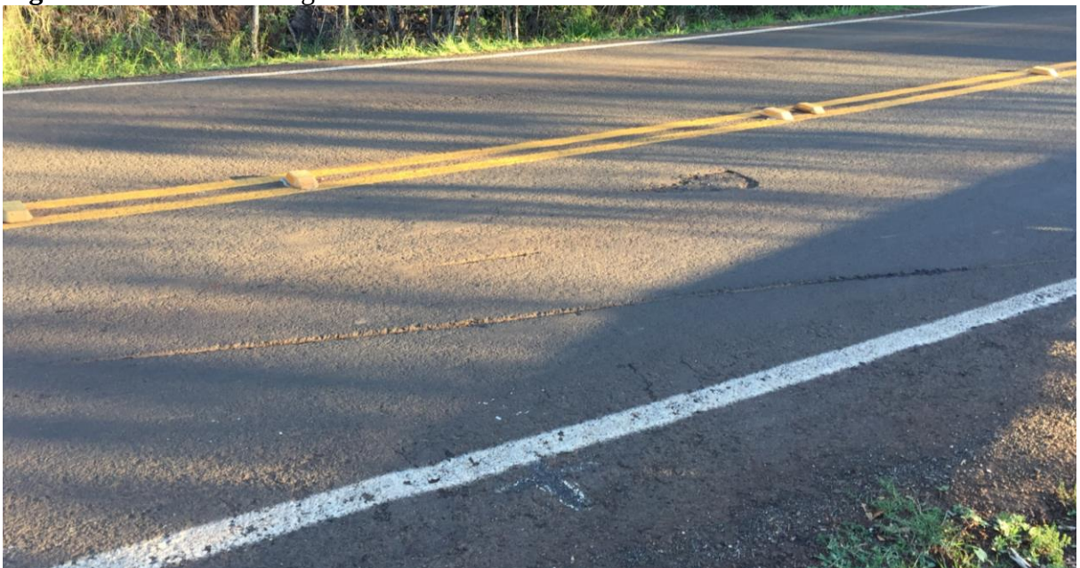
Figura 15: Marcas de desgaste.
