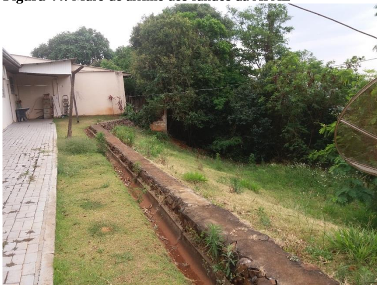
Figura 44: Muro de arrimo aos fundos da APAE
