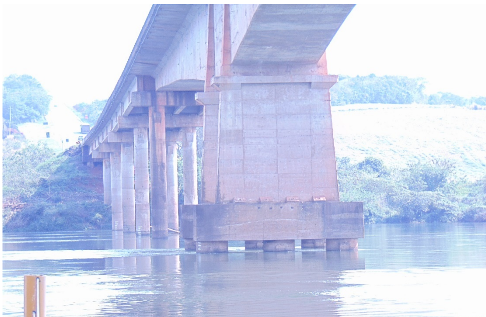
Figura 16: Aduela de arranque 2, Pórticos de 2 pilares.
