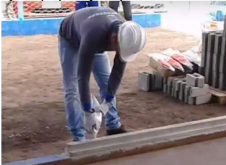
Figura 5: Aplicação da argamassa polimérica.
