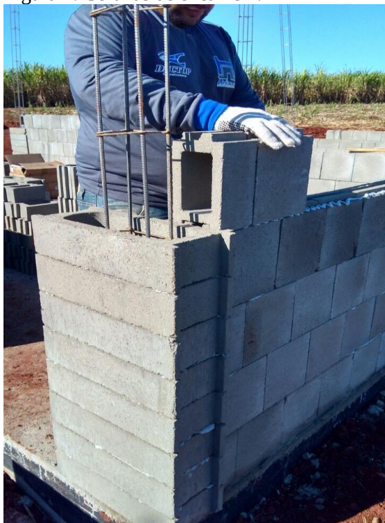
Figura 7: Colunas de encaixe 1.
