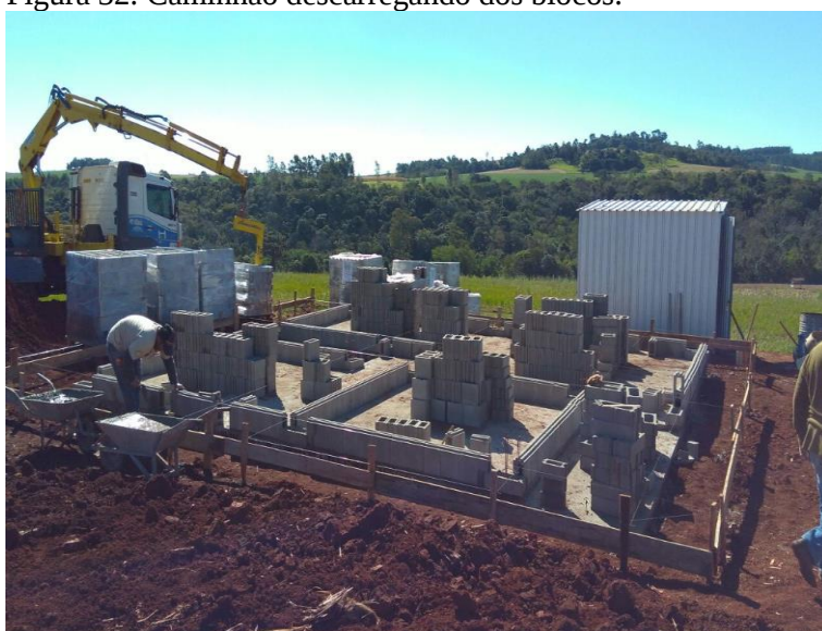
Figura 32: Caminhão descarregando dos blocos.
