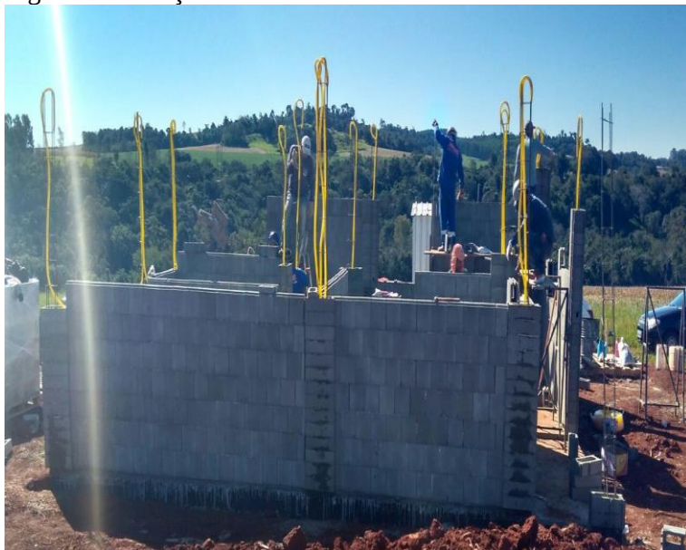
Figura 9 Instalação elétrica 1.
