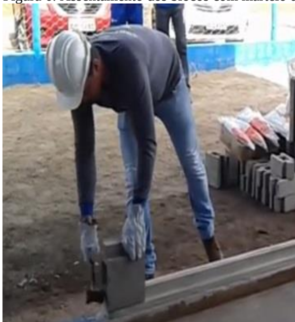
Figura 6: Assentamento dos blocos com martelo de borracha.
