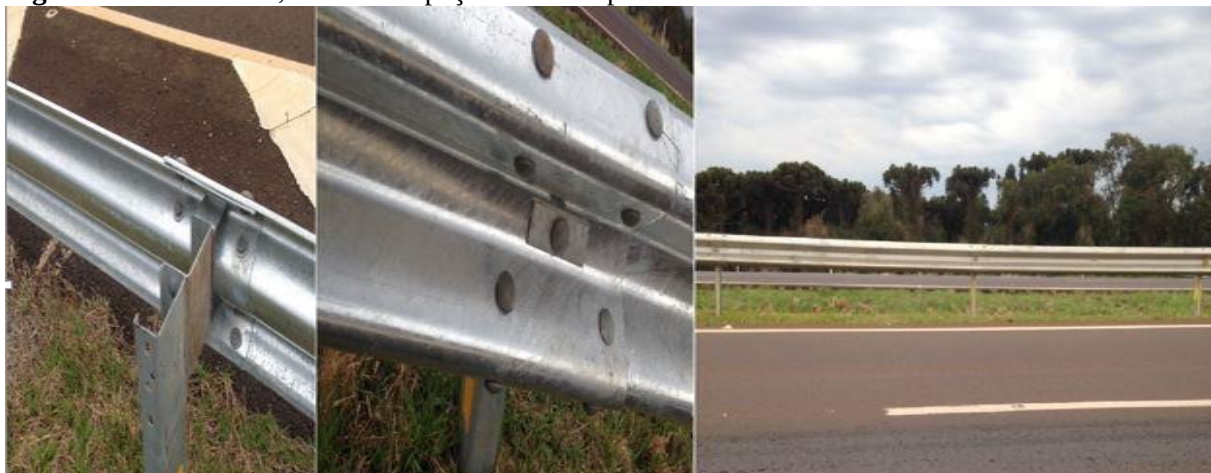
Figura 9: Atenuadores, lâmina e espaçamento dos postes.
