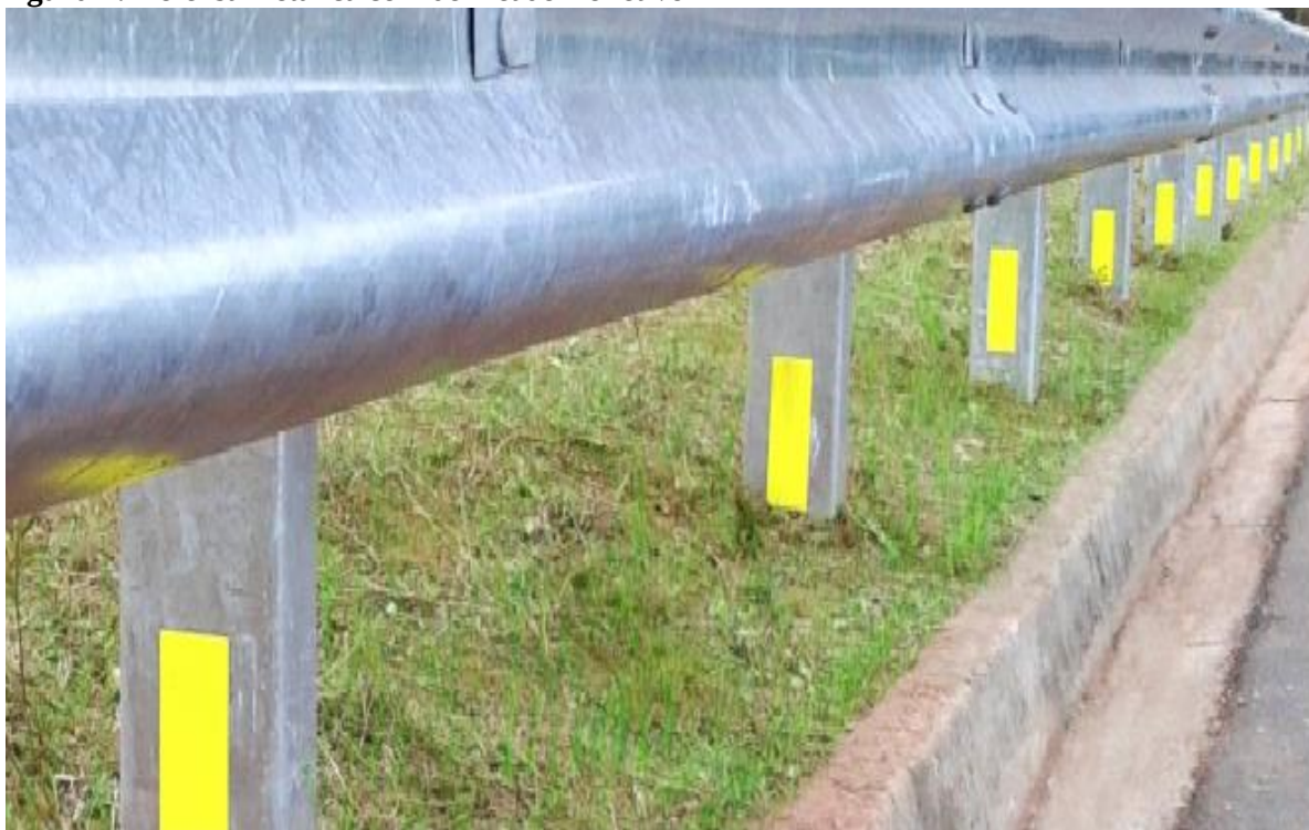
Figura 1: Defesa metálica com delineador refletivo
