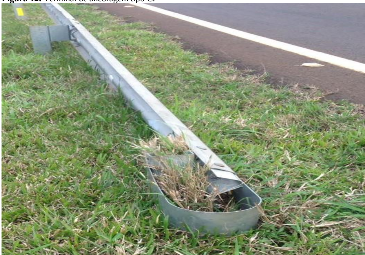
Figura 12: Terminal de ancoragem tipo C.
