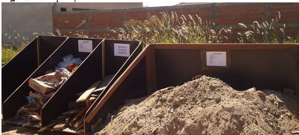
Figura 24: Separação dos resíduos de uma obra.
