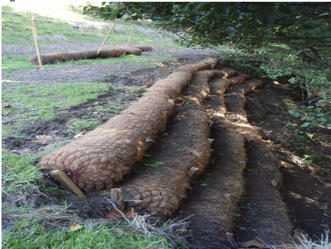
Figura 04: Biorrolos de fibra de coco instalados em terreno com declive.
