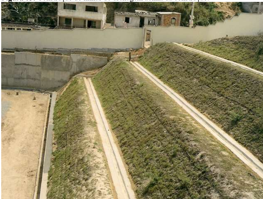
Figura 03: Construção de linhas de drenagem acima da construção.
