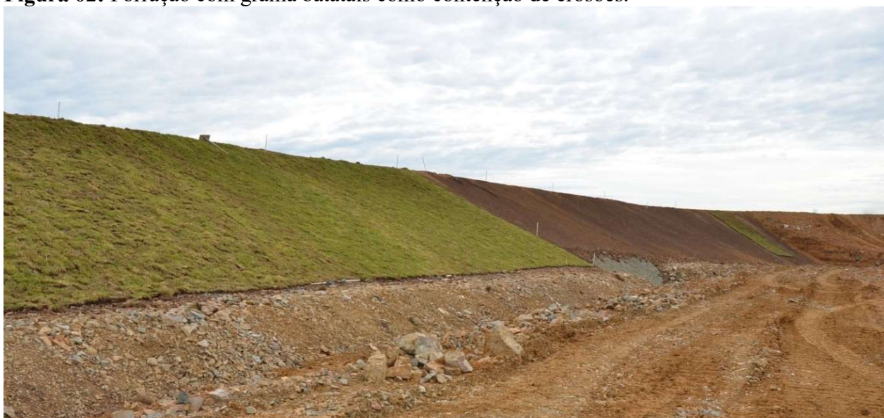
Figura 02: Forração com grama batatais como contenção de erosões.
