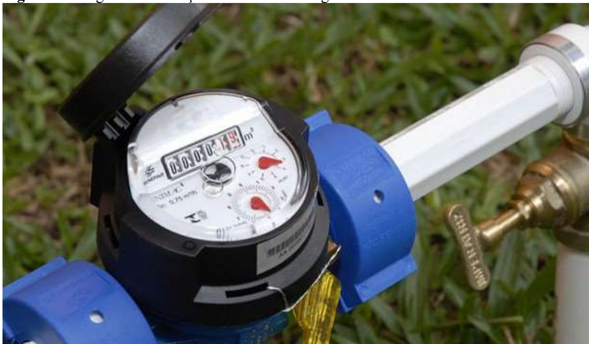
Figura 15: Registro de medição do consumo de água.
