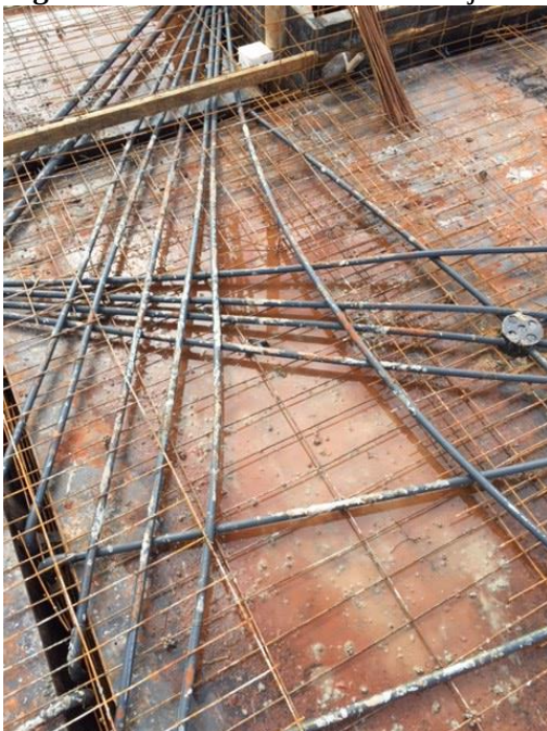
Figura 5: Eletrodutos locados em laje.
