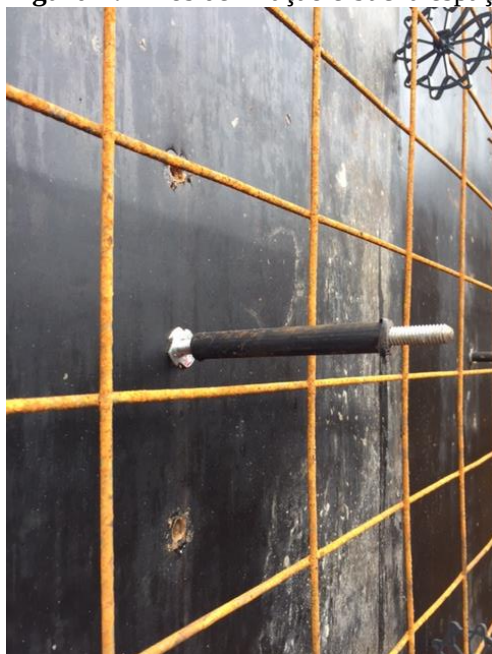
Figura 1: Pinos de fixação e bucha espaçadora.
