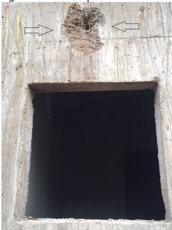
Figura 22: Armadura exposta.
