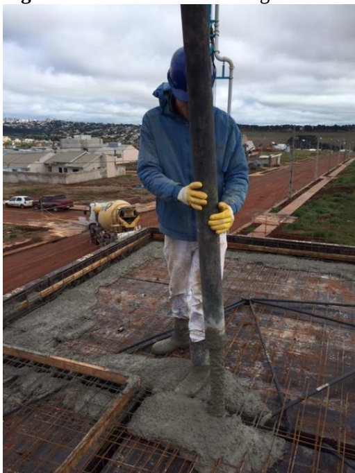
Figura 6: Processo de concretagem.
