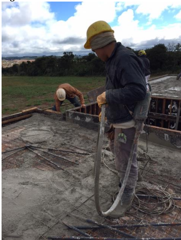
Figura 8: Adensamento do concreto.
