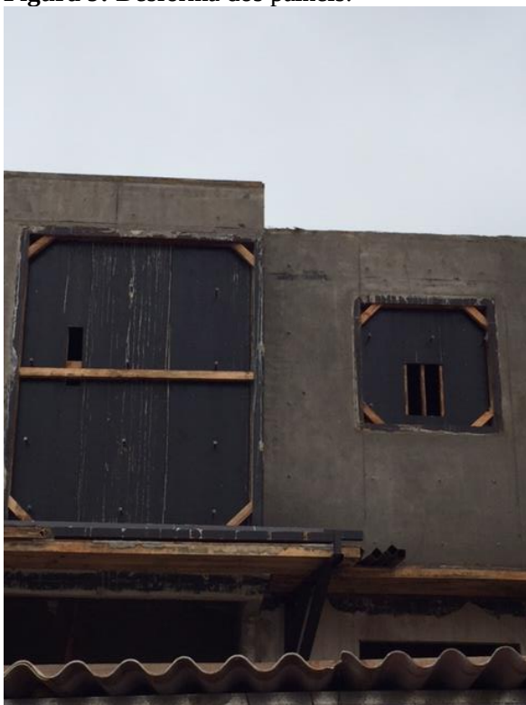
Figura 9: Desforma dos painéis.
