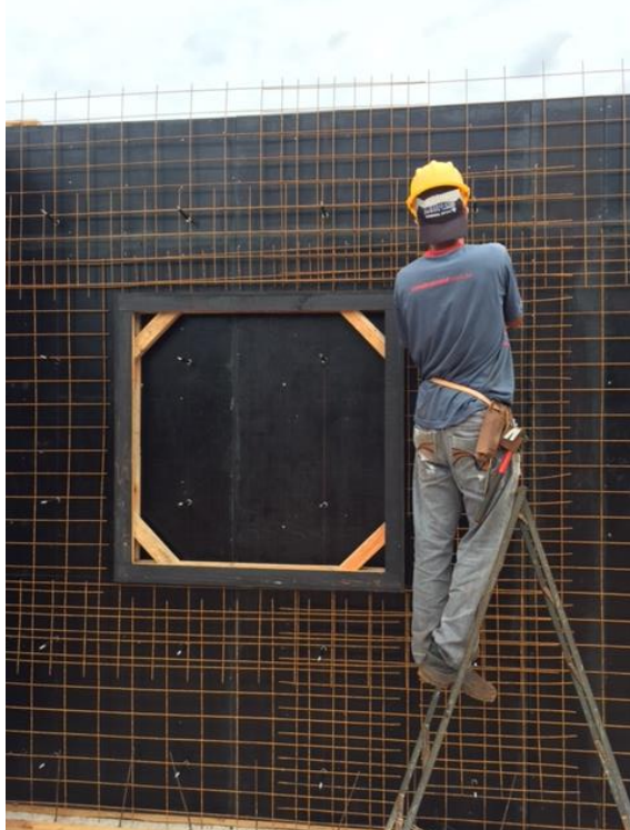
Figura 3: Tela eletro soldada no contorno da janela.
