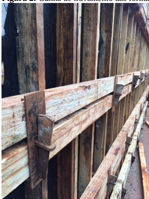
Figura 2: Cunha de travamento das fôrmas.
