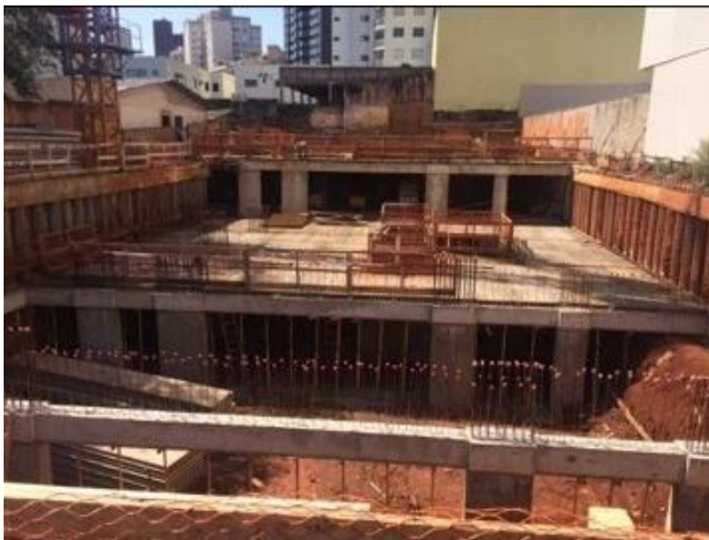
Figura 2 – Periferia protegida por guarda-corpo.
