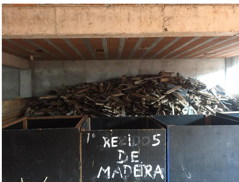
Figura 3 – Armazenamento de resíduos de madeira.
