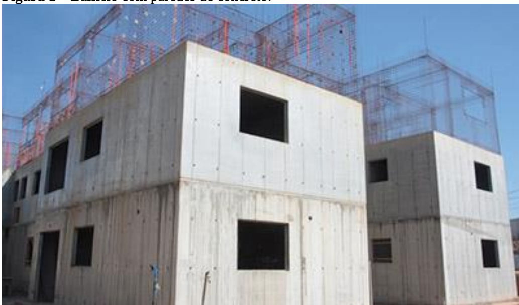
Figura 1 – Edifício com paredes de concreto.
