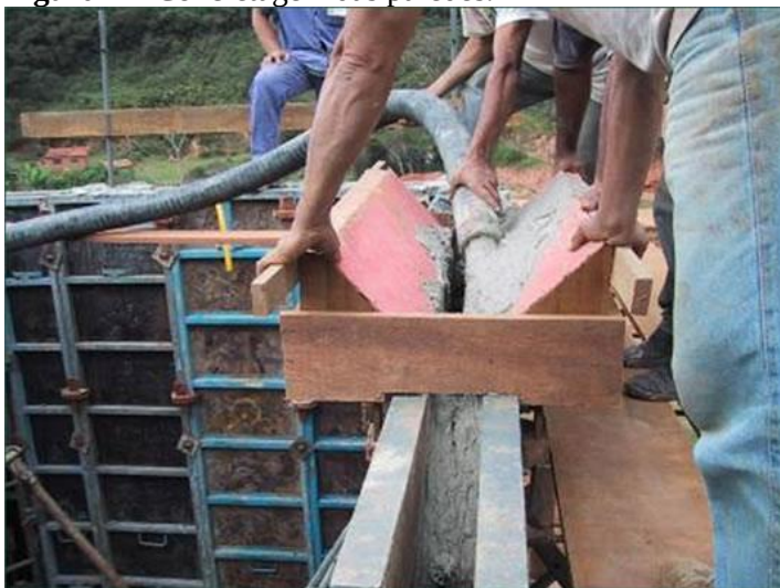
Figura 7 – Concretagem das paredes.
