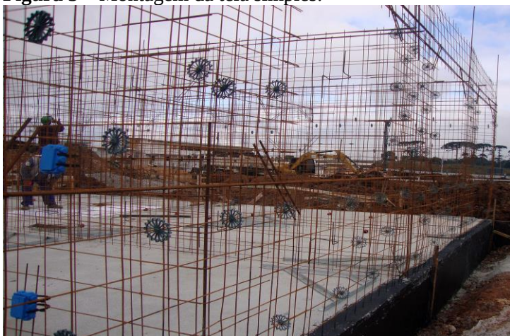
Figura 5 – Montagem da tela simples.
