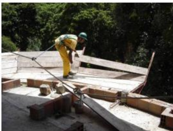
Figura 23: Processo de desmontagem da bandeja convencional
