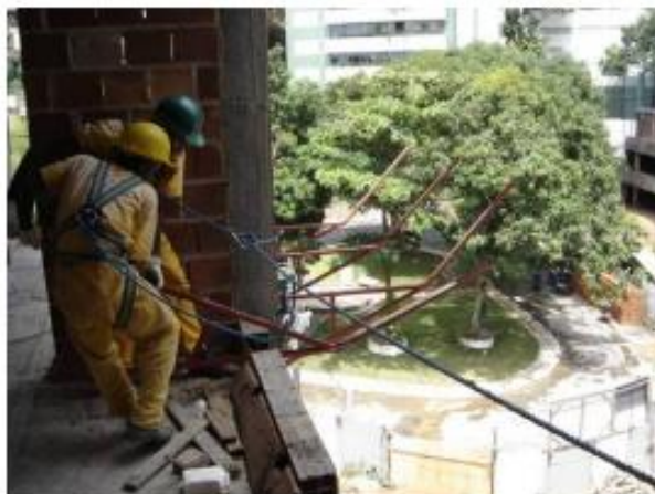
Figura 24: Colocação dos perfis
