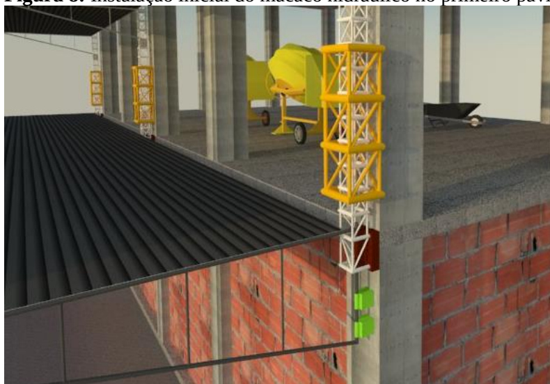
Figura 8: Instalação inicial do macaco hidráulico no primeiro pavimento
