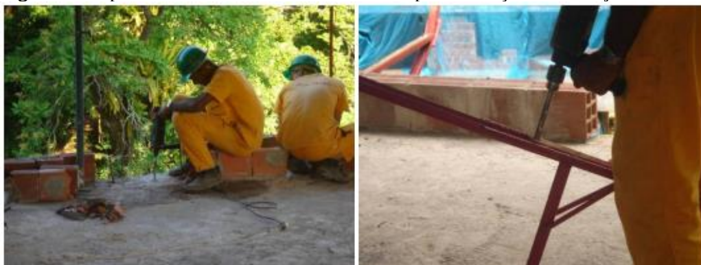
Figura 18: Operários fazendo os furos necessários para a fixação da bandeja
