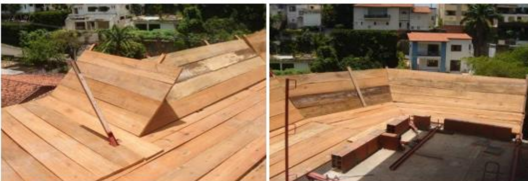
Figura 21: Aspecto final da bandeja convencional de proteção
