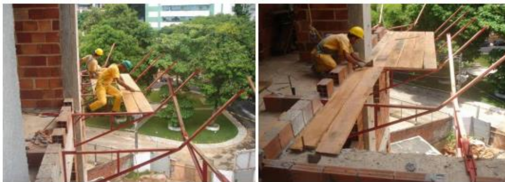
Figura 19: Colocação das tábuas nos perfis
