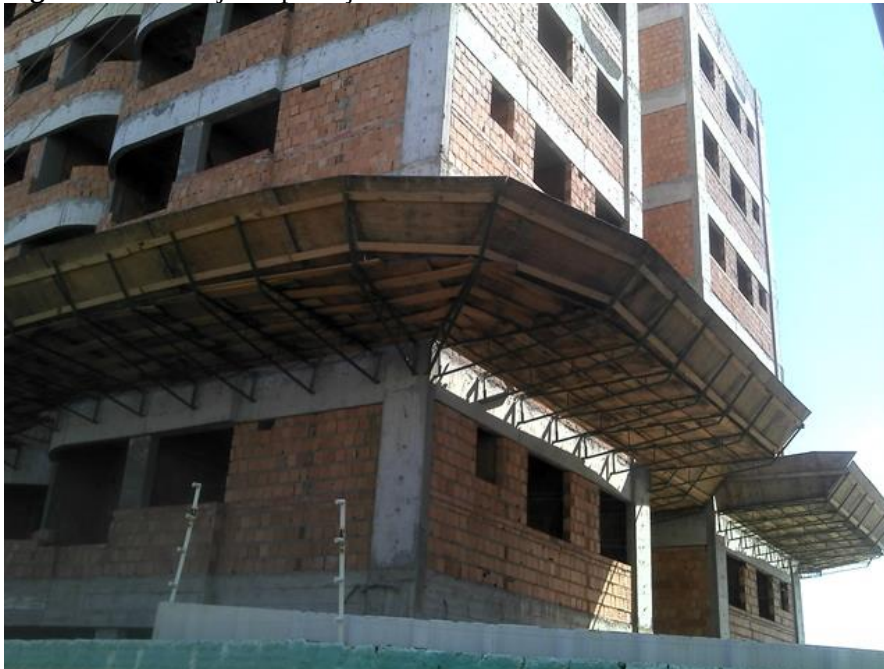
Figura 22: Bandeja de proteção executada com madeirites
