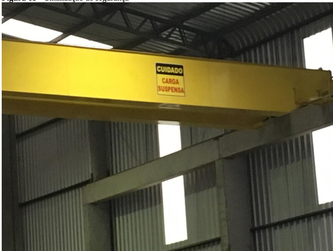
Figura 68 – Sinalização de segurança
