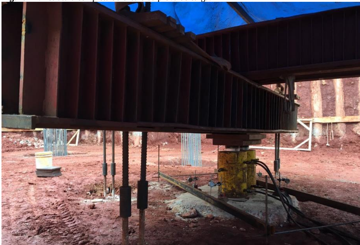
Figura 14: Estrutura completa do ensaio da prova de carga.
