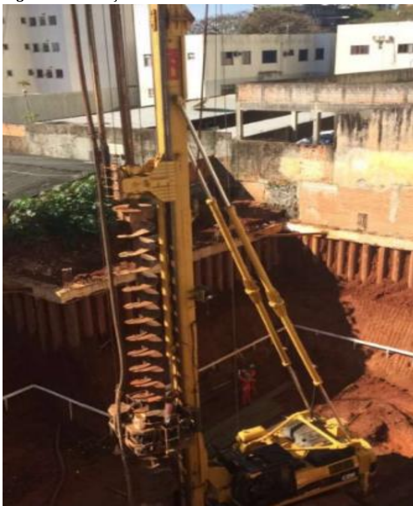
Figura 13: Execução da estaca de ensaio.
