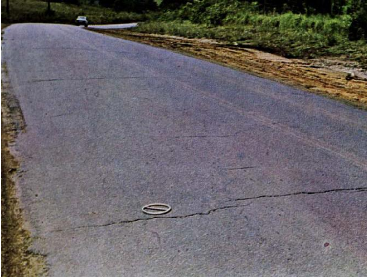
Figura 2: Trinca Transversal
