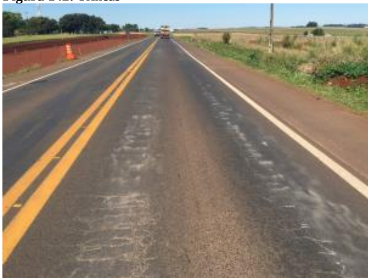
Figura 142: Trincas
