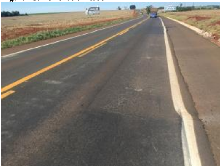
Figura 15: Remendo trincado
