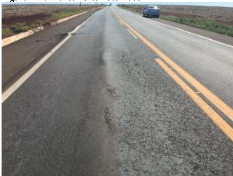
Figura 214: Afundamento Localizado
