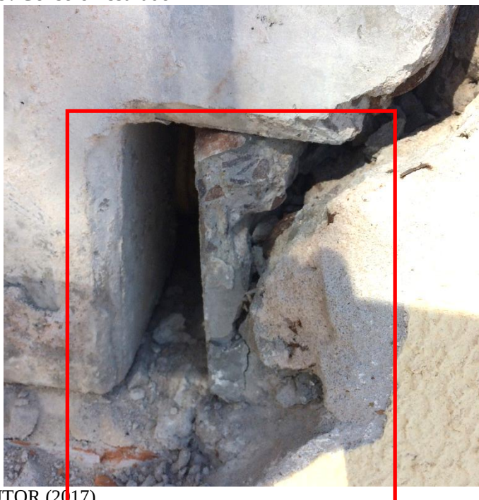
Figura 29: Consolo fissurado
