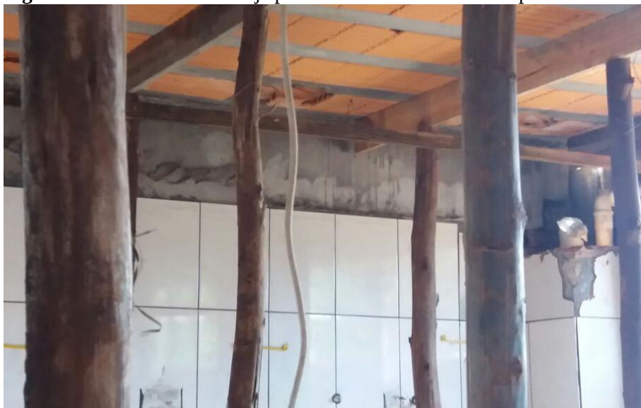
Figura 30: Escoramento da laje por meio de escoras de eucalipto
