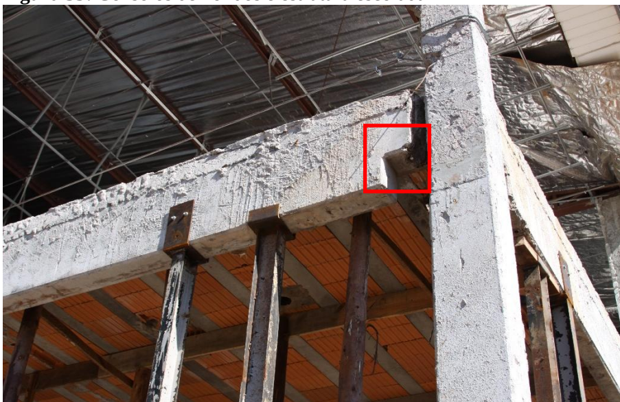
Figura 35: Consolos demolidos e estrutura escorada
