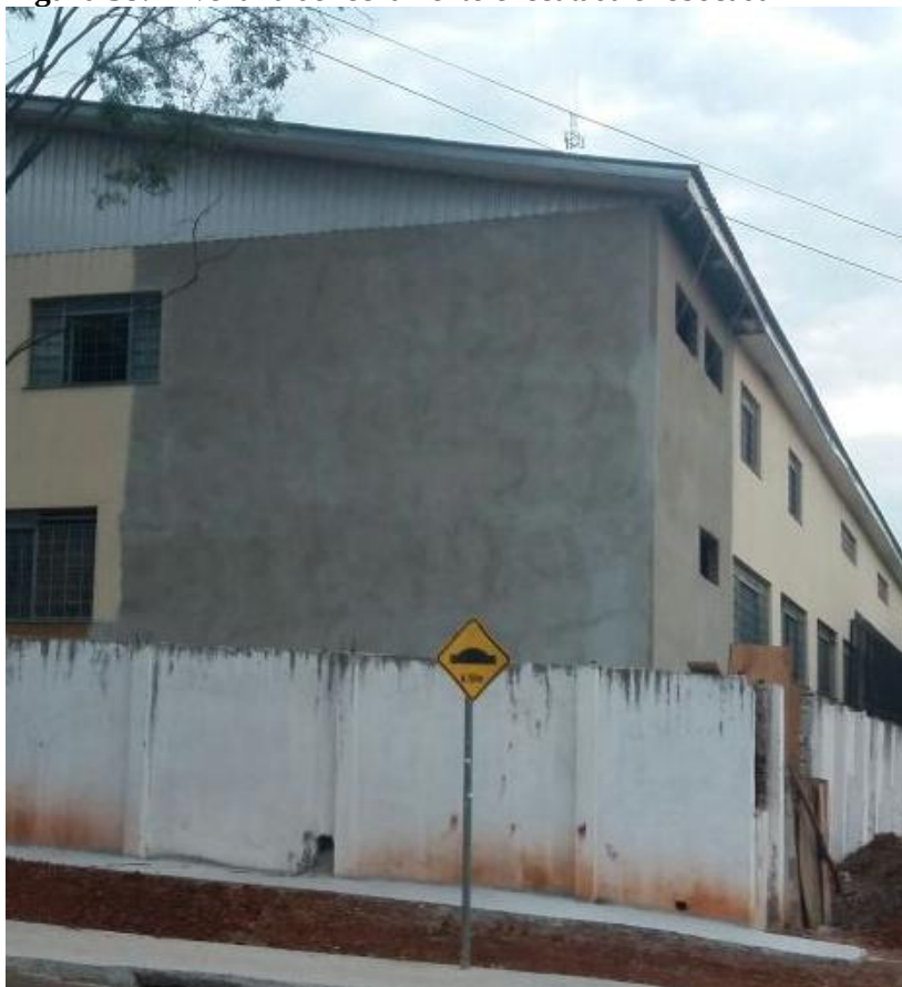
Figura 38: Alvenaria de fechamento executada e rebocada
