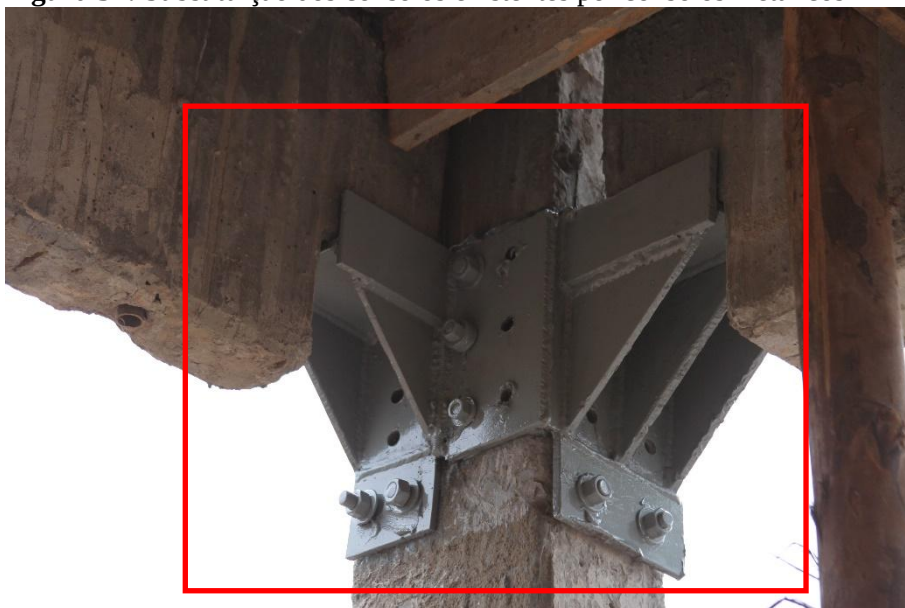
Figura 37: Substituição dos consolos existentes por consolos metálicos
