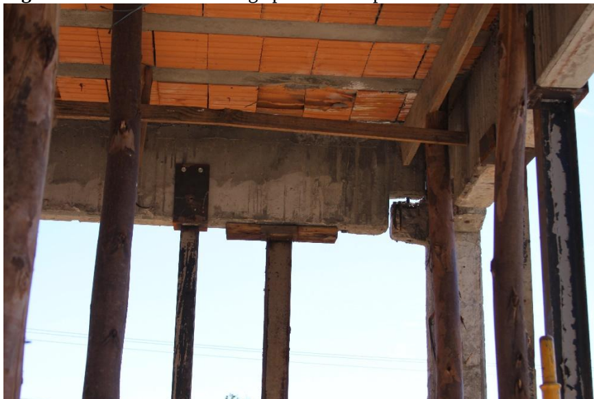
Figura 31: Escoramento da viga por meio de pilares metálicos
