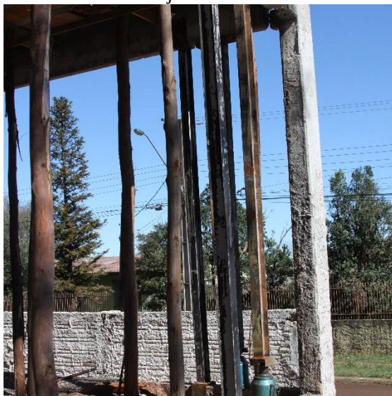
Figura 33: Levantamento da laje com macaco mecânico
