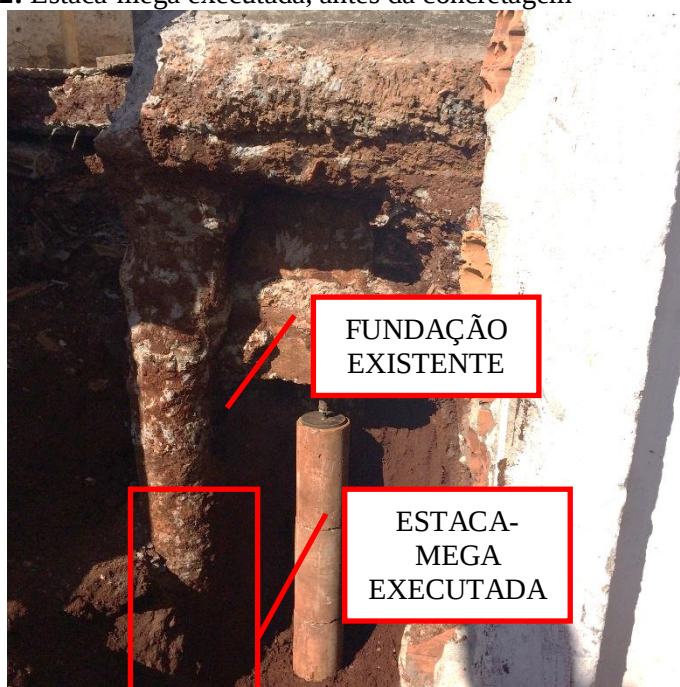
Figura 32: Estaca-mega executada, antes da concretagem
