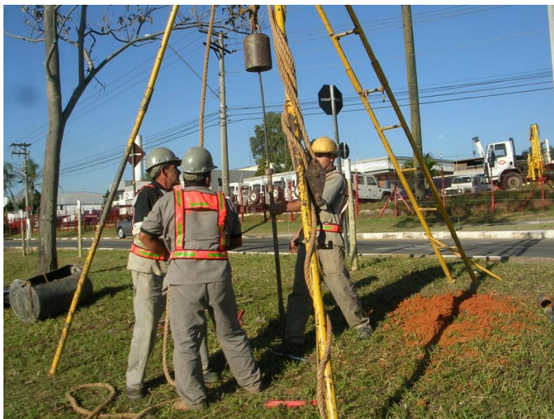
Figura 02: Execução de sondagem
