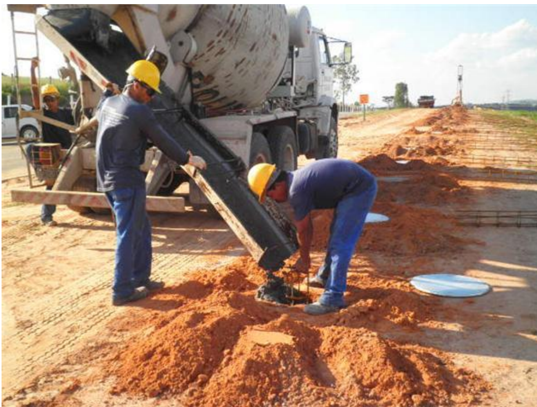
Figura 05: Etapas na execução da estaca
