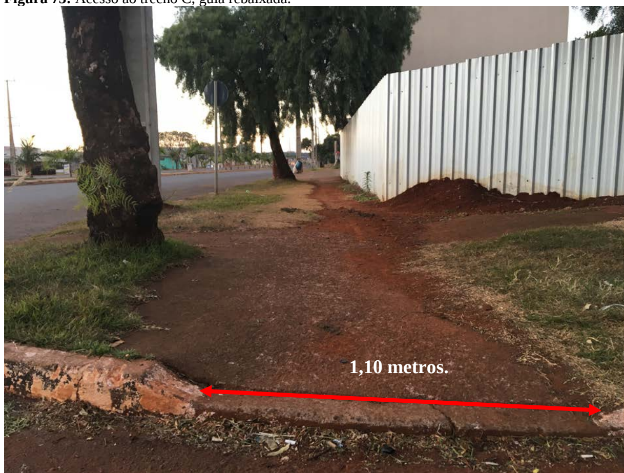
Figura 73: Acesso ao trecho C, guia rebaixada.
