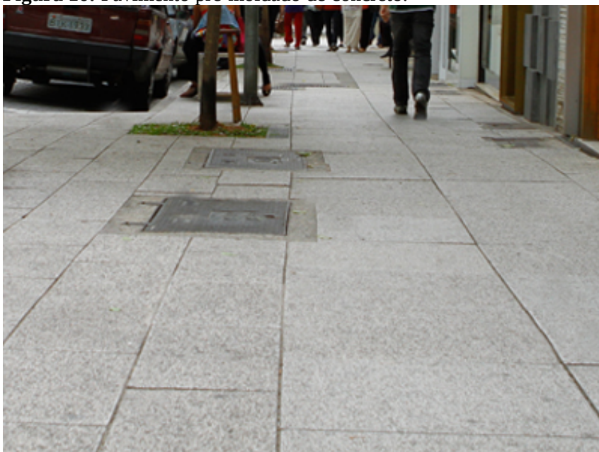
Figura 16: Pavimento pré-moldado de concreto.
