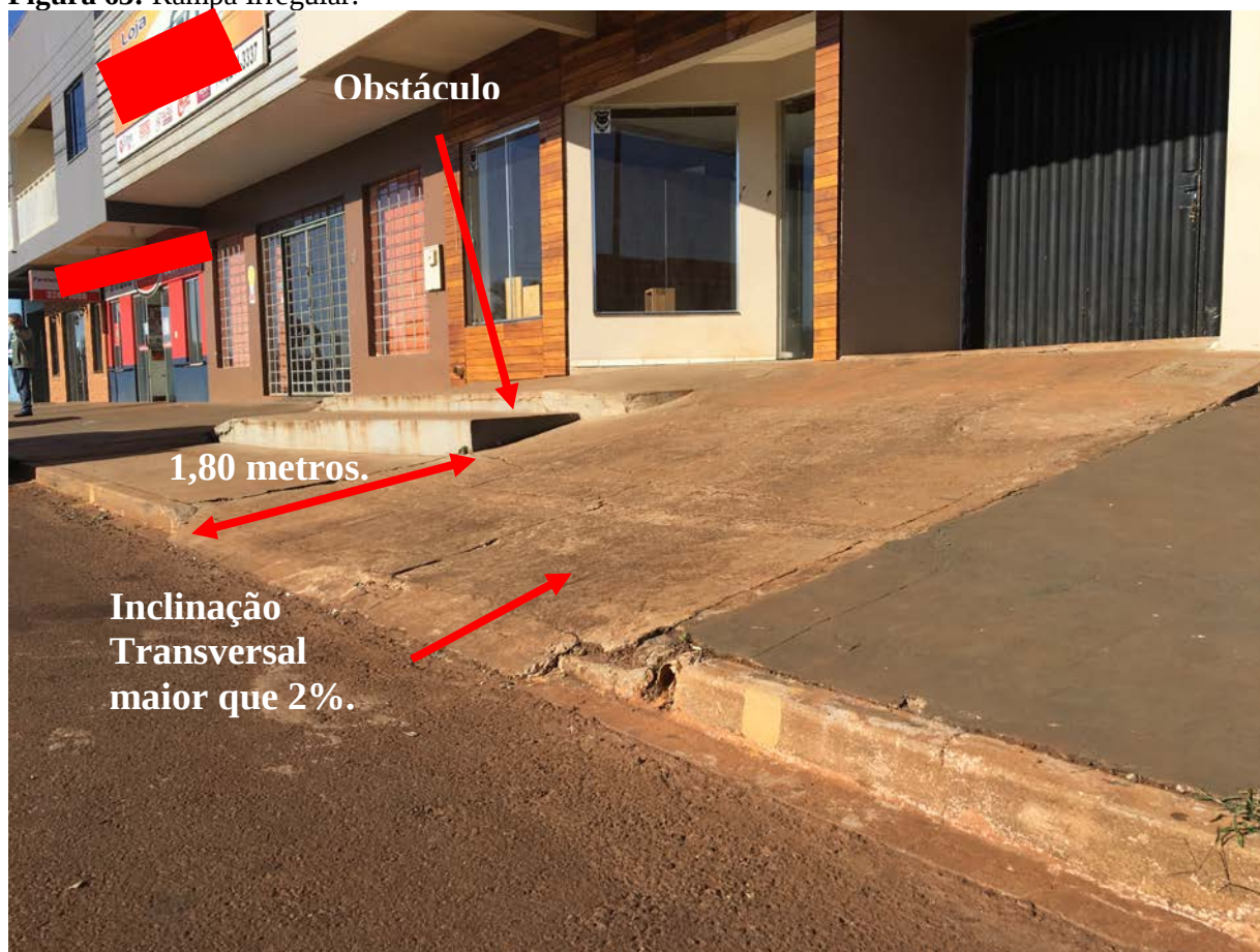
Figura 63: Rampa Irregular.
