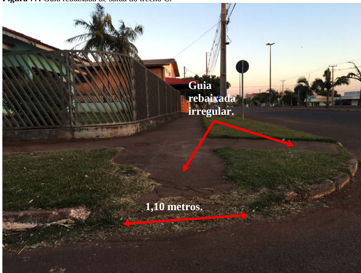
Figura 77: Guia rebaixada de saída do trecho C.
