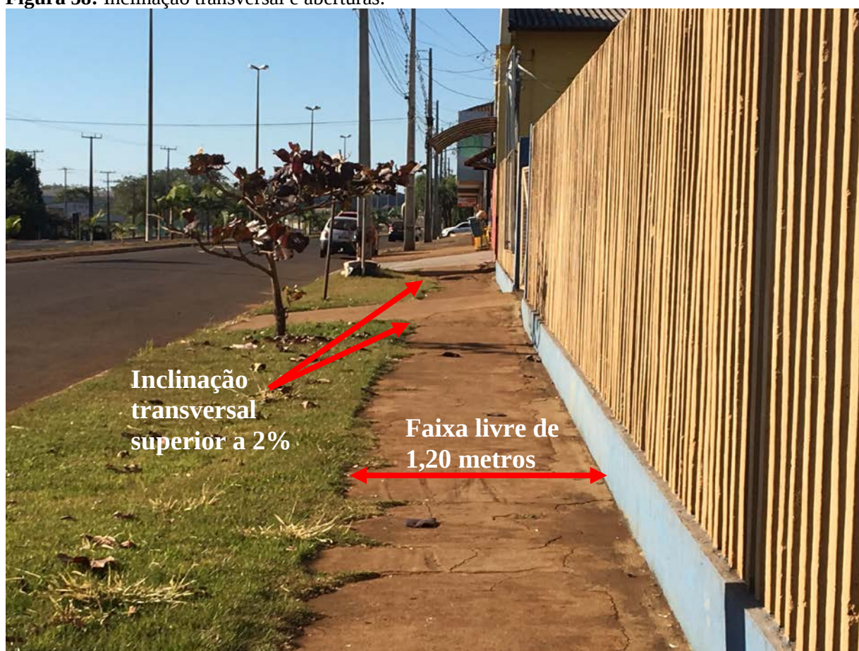
Figura 58: Inclinação transversal e aberturas.
