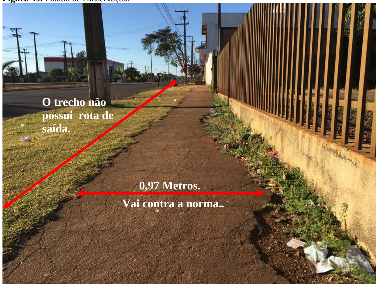
Figura 45: Estado de conservação.
