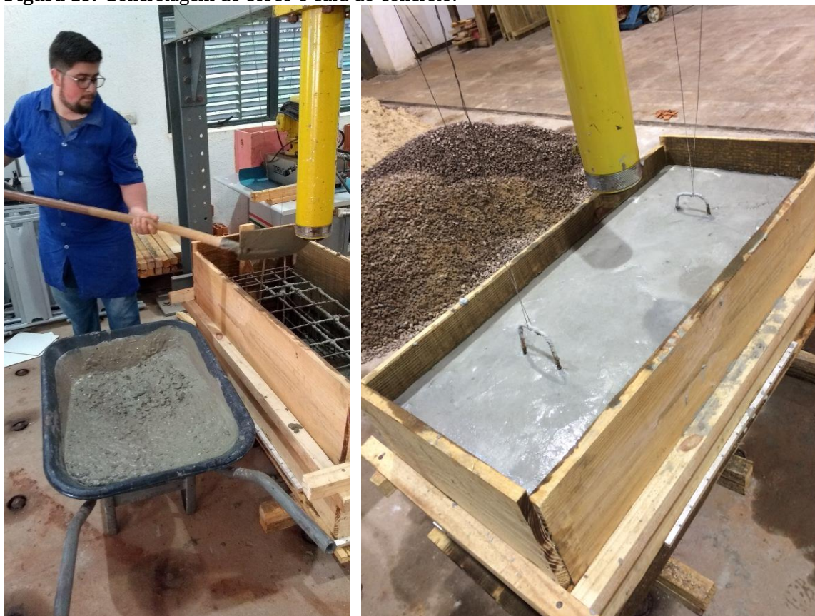
Figura 18: Concretagem do bloco e cura do concreto.
