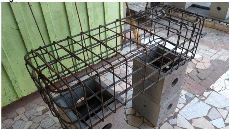
Figura 16: Armadura finalizada.
