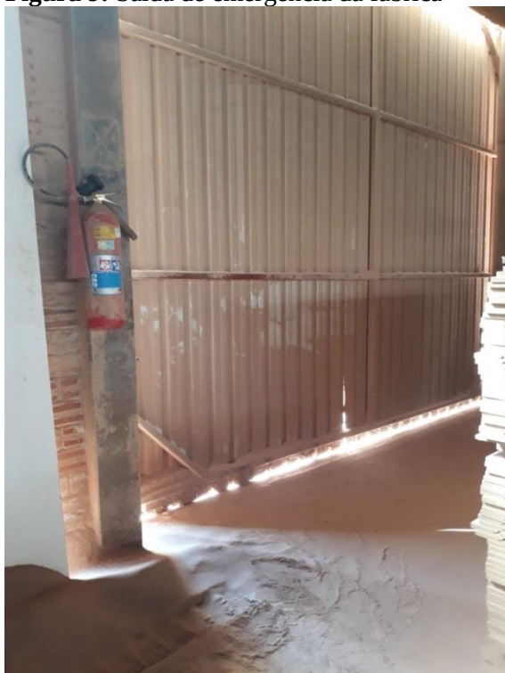
Figura 9: Saída de emergência da fábrica
