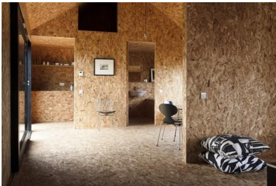
Figura 46 – Ambiente executado em OSB.
