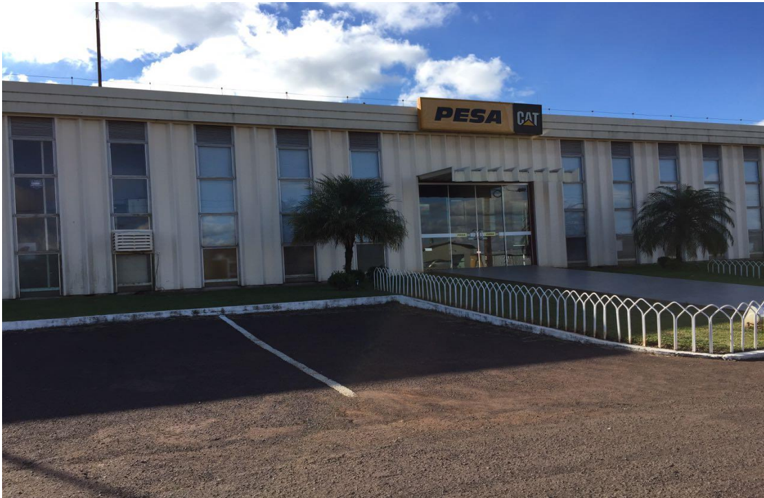
Figura 10: Escritório administrativo da empresa Paraná Equipamentos – SA.
