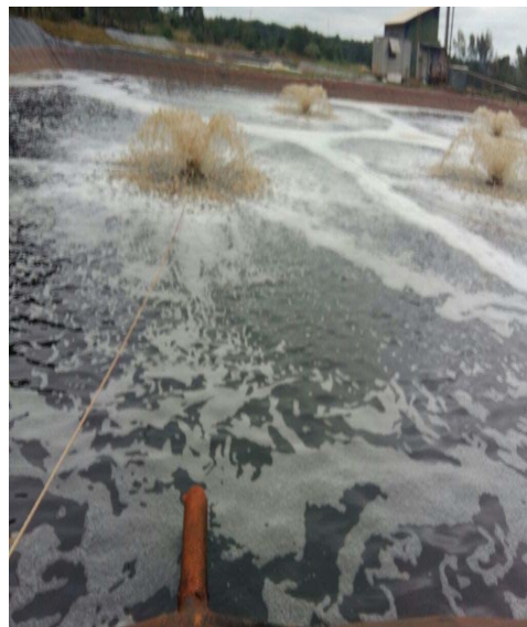
Figura 9: Lagoa de tratamento de chorume bruto do Aterro Sanitário de Cascavel-PR
