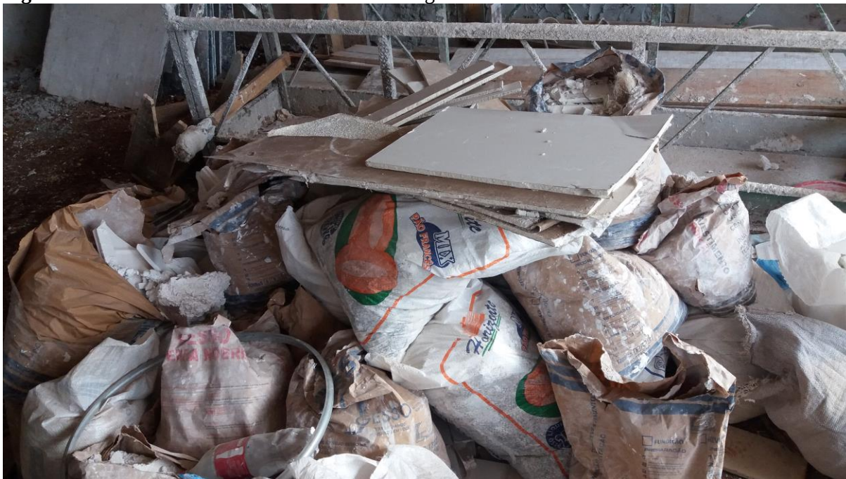
Figura 3: Local de armazenamento de resíduos de gesso na Obra 1
