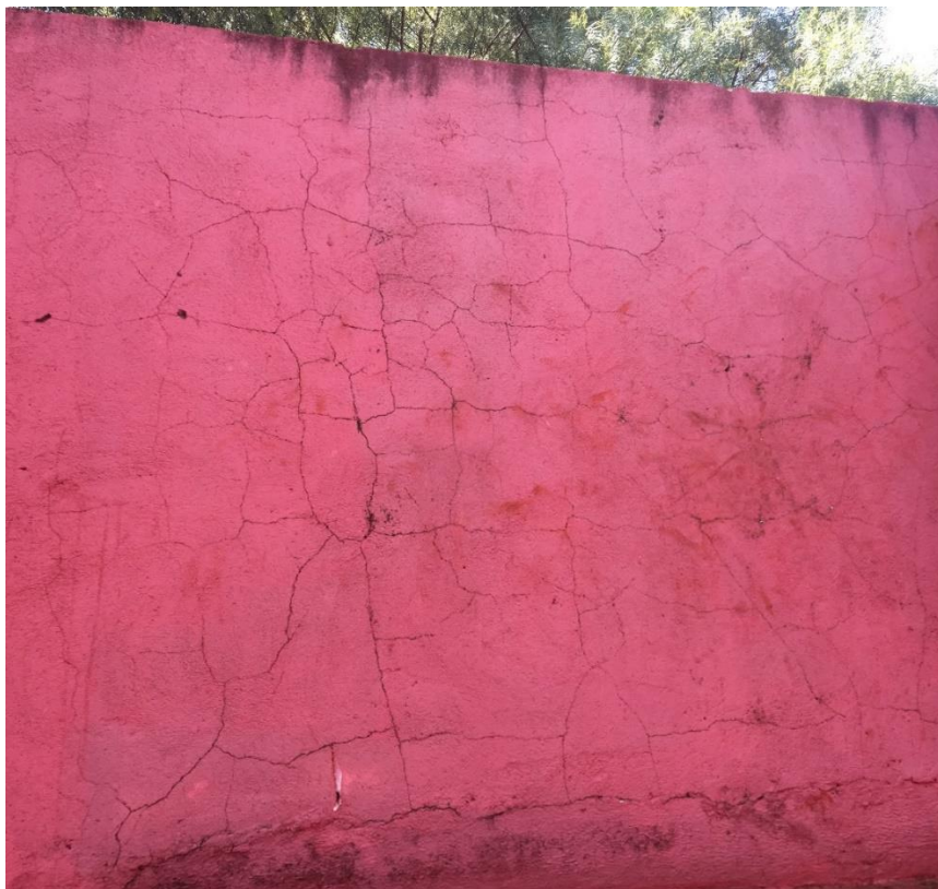
Figura 21: Fissuras mapeadas.
