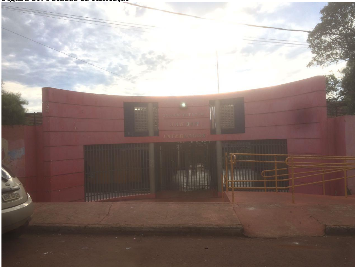
Figura 16: Fachada da edificação
