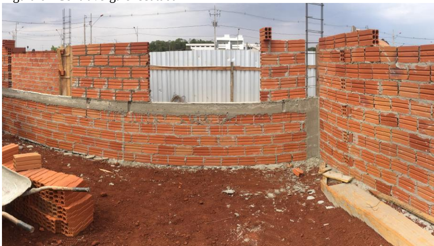
Figura 6 - Contraverga executada
