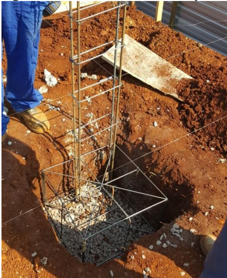
Figura 2 - Estacas e blocos de fundação
