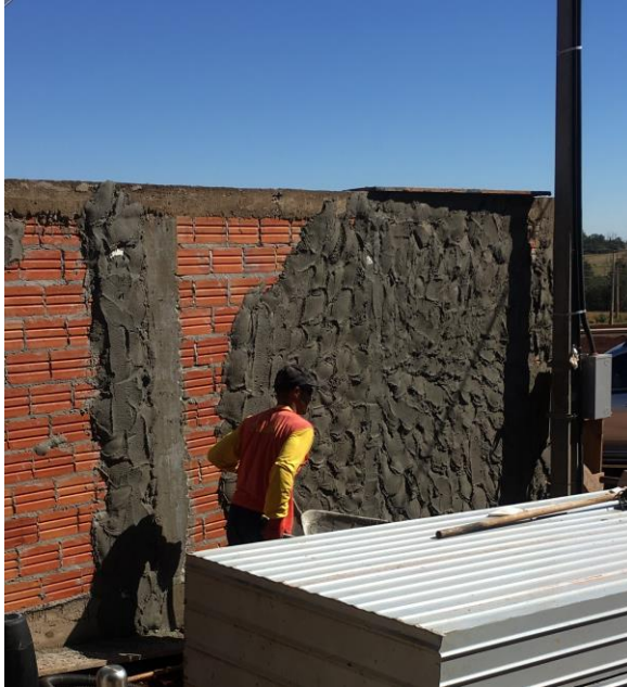
Figura 11 - Reboco externo
