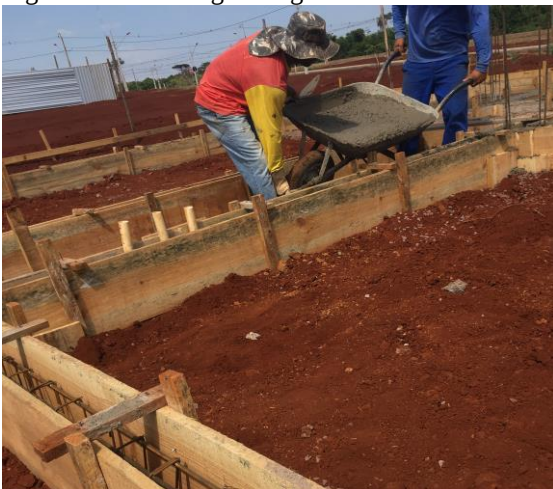
Figura 3 - Concretagem Viga Baldrame
