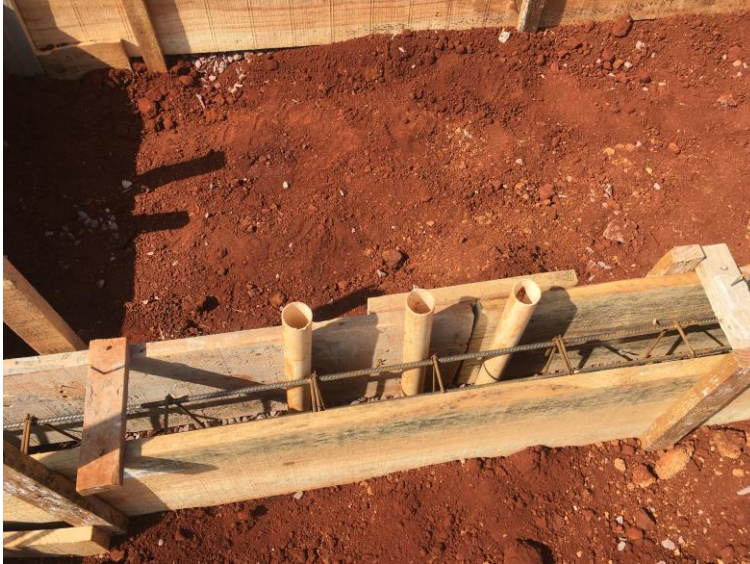
Figura 8 - Esperas para hidráulica na viga baldrame
