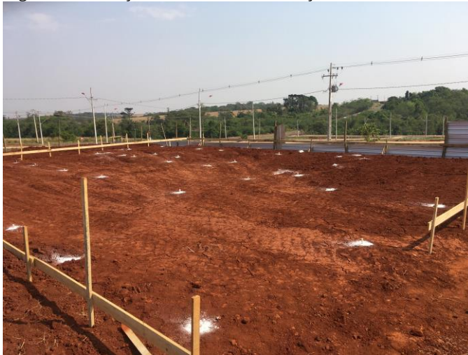
Figura 1- Marcação das estacas de fundação
