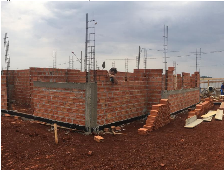
Figura 4 - Assentamento dos Tijolos
