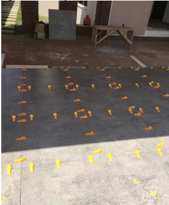
Figura 12 - Colocação de Revestimento
