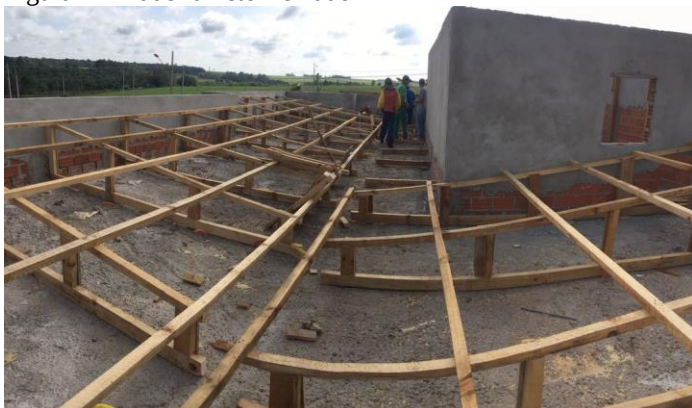
Figura 7 - Madeiramento Telhado
