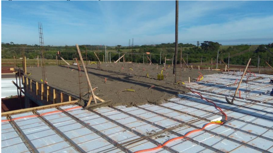
Figura 5 - Concretagem da laje
