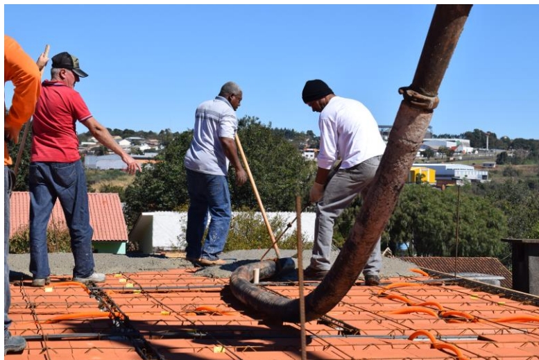
Figura 18 – Concretagem em execução
