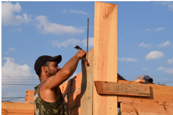
Figura 2 – Montando as caixarias
