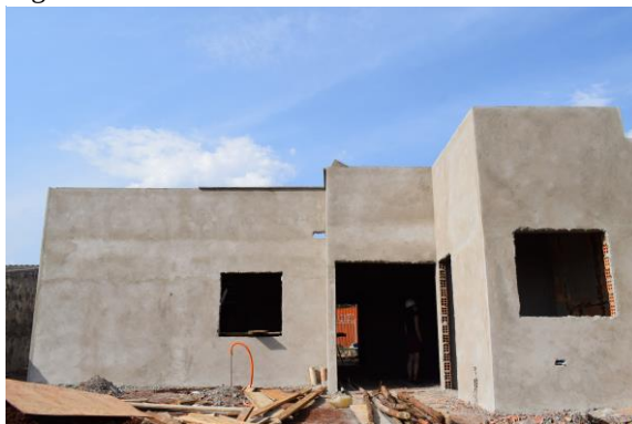
Figura 21 – Reboco externo
