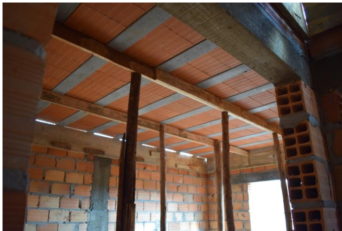
Figura 14 – Vista das lajotas no pavimento inferior
