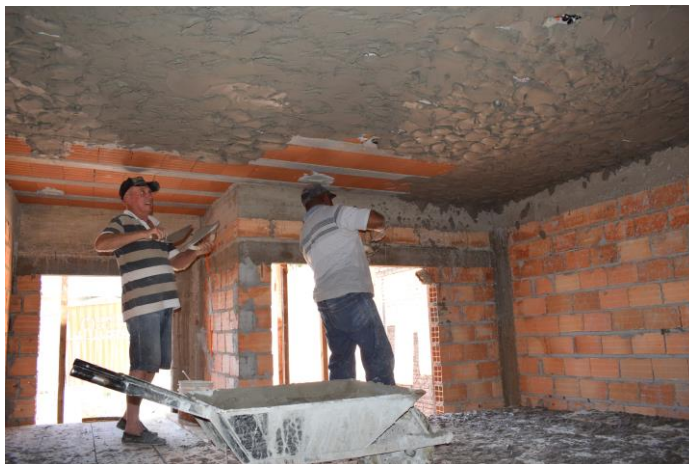
Figura 22 – Reboco do forro em execução
