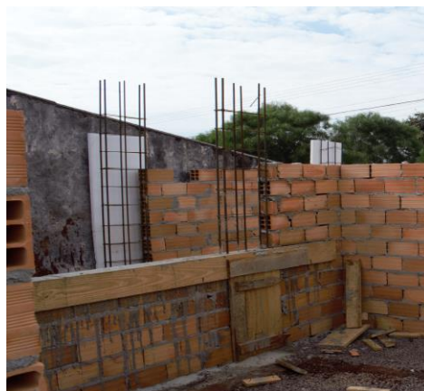
Figura 6 – Caixaria da contraverga
