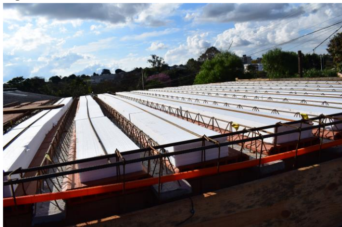
Figura 15 – Preenchimento com EPS
