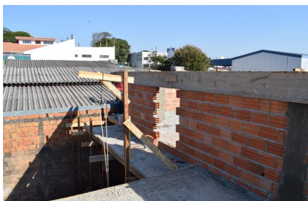
Figura 20 - Platibanda
