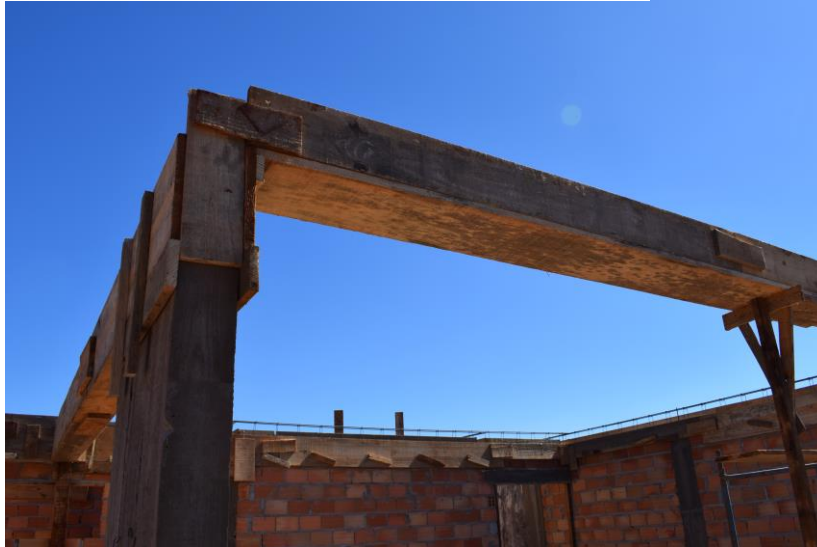
Figura 5 – Caixaria com pilar concretado
