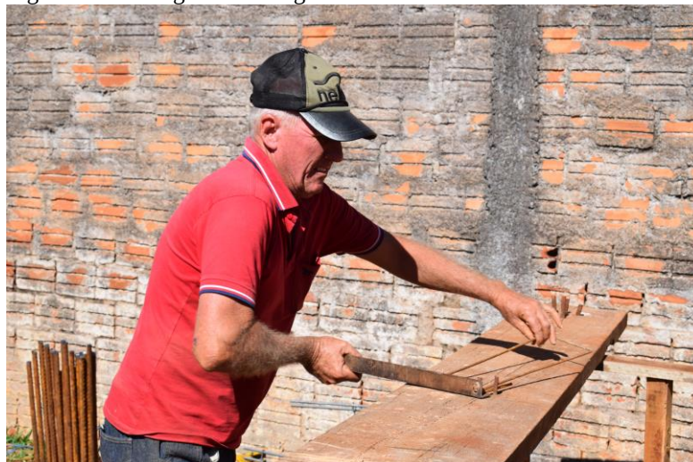
Figura 8 – Montagem da ferragem
