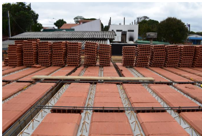
Figura 13 – Lajotas posicionadas
