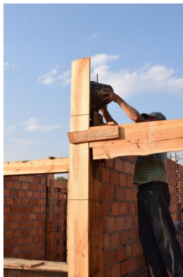
Figura 4 – Concretagem manual da viga e pilar
