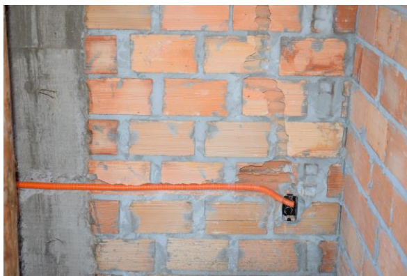
Figura 17 – Instalação de ponto de tomada
