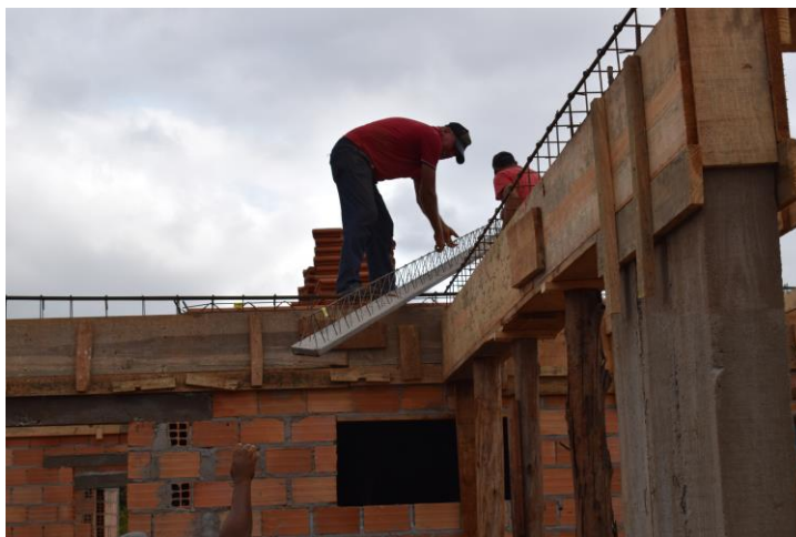
Figura 11 – Levantando a vigota
