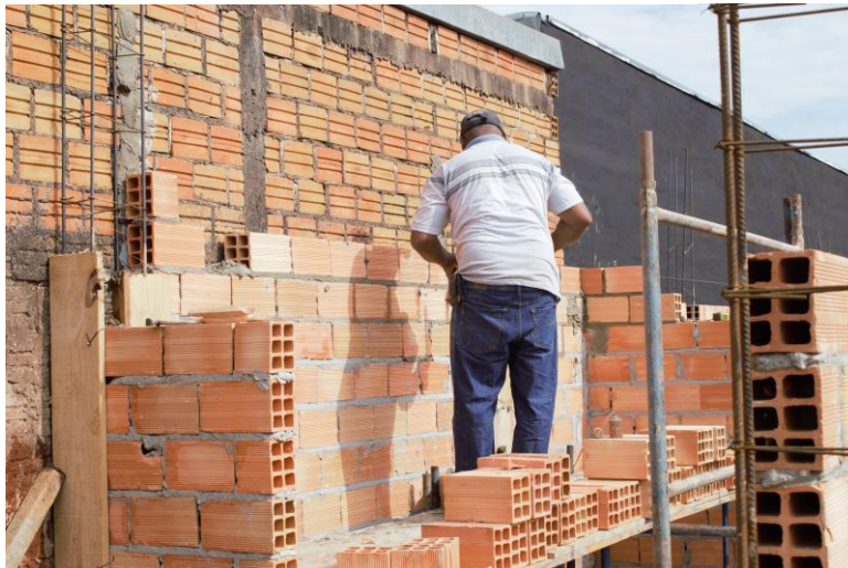
Figura 1 – Levantando as fiadas da alvenaria
