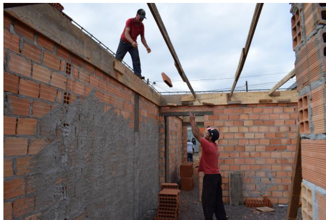
Figura 12 – Transporte das lajotas
