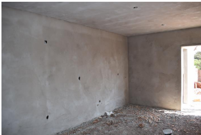
Figura 24 – Reboco finalizado
