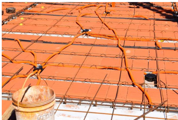
Figura 16 – Instalação dos pontos de luz
