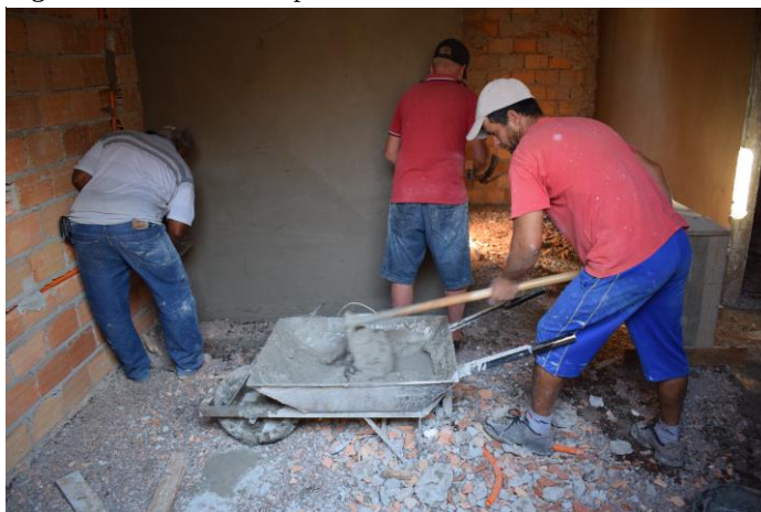
Figura 23 – Reboco das paredes internas
