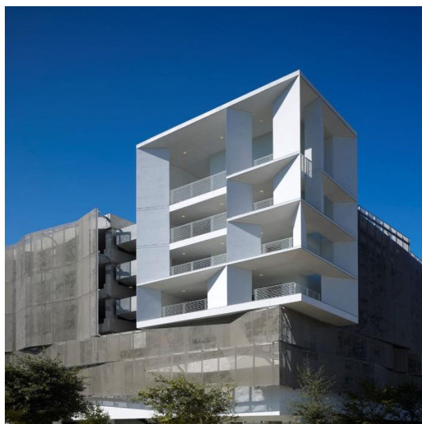
Figura 07 – Foto do Edifício Garagem Mission Bay Block 27.
