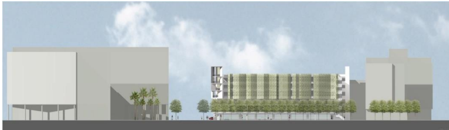
Figura 08 – Foto do Edifício Garagem Mission Bay Block 27.
