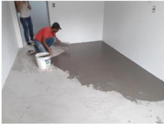
Figura 07 – Execução da regularização do contrapiso
