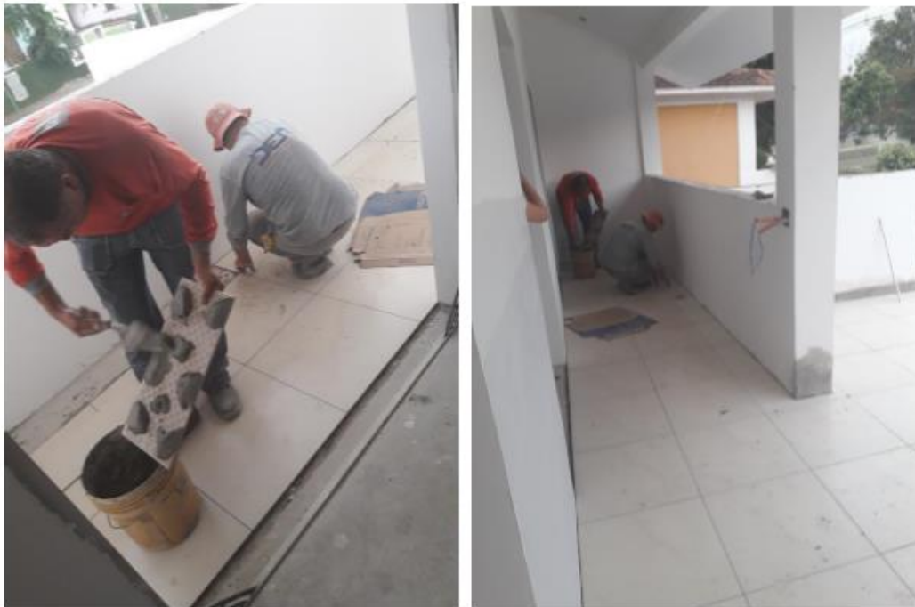
Figura 06 – Execução de assentamento de piso
