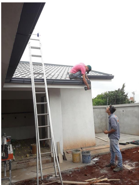
Figura 12 – Instalação de calhas
