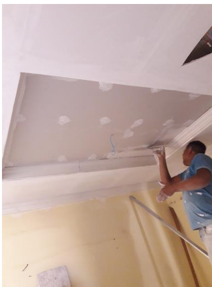
Figura 11 – Instalação do gesso
