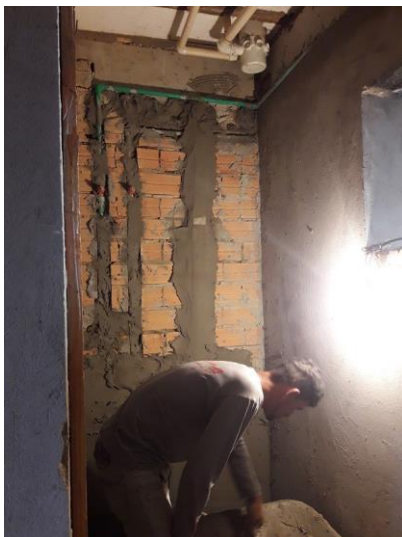
Figura 08 – Instalação de hidráulica
