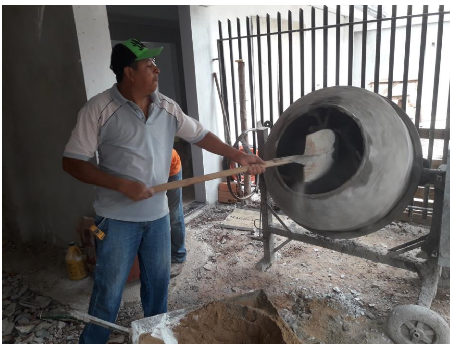
Figura 03 – Preparo de massa para reboco
