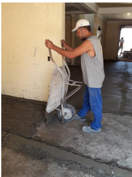
Figura 05 – Concretagem contrapiso
