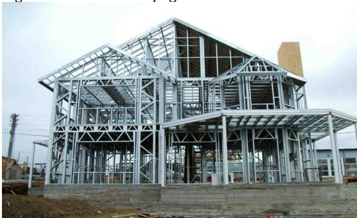
Figura 1: estrutura em aço galvanizado.
