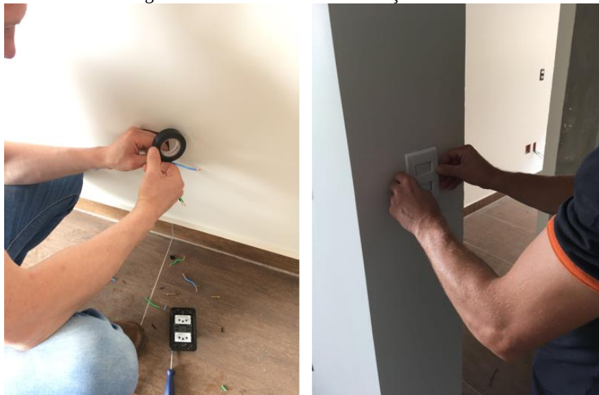
Imagem 12 – Acabamento das instalações elétricas.
