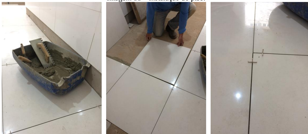
Imagem 11 – Instalação do piso.
