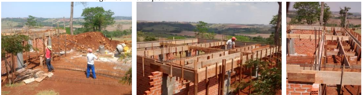
Imagem 06 – Instalação armadura em formas de madeira.
