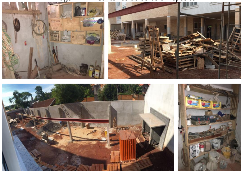
Imagem 14 – Canteiros de obras e Depósito
