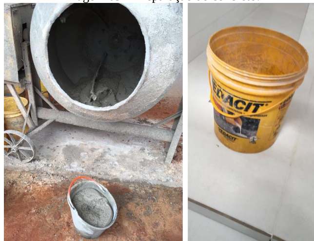
Imagem 09 – Preparação do concreto.
