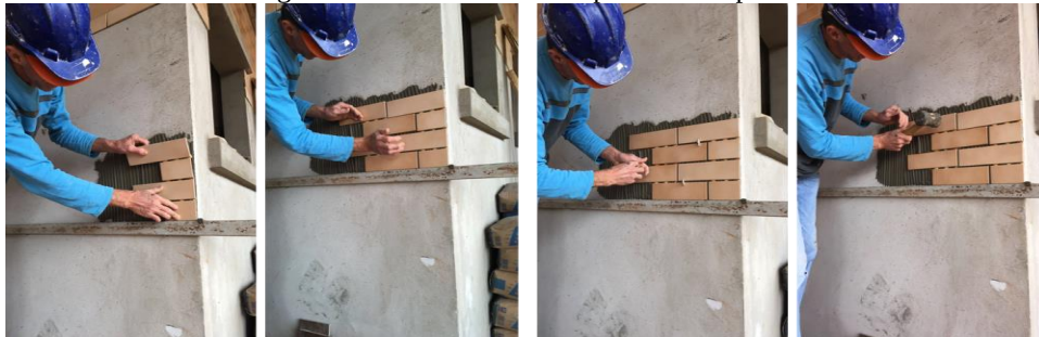
Imagem 04 - Assentamento de pastilhas na parede.
