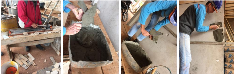
Imagem 03 – Assentamento de pastilhas na parede.
