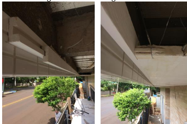
Imagem 01 – Forro em gesso comum.
