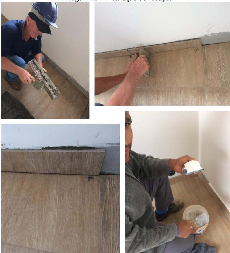
Imagem 10 – Instalação do rodapé.
