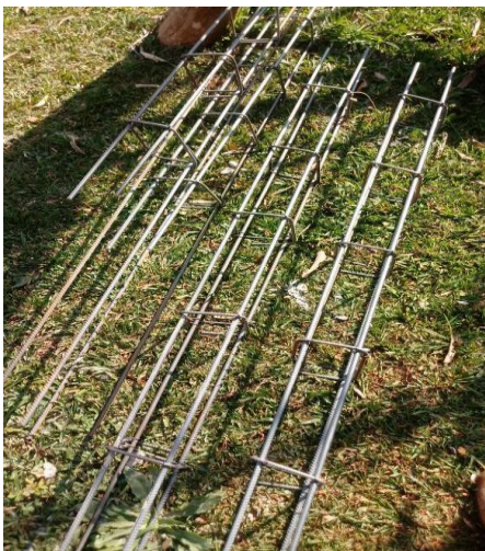
Figura 03: Armação das ferragens executadas na obra 01.
