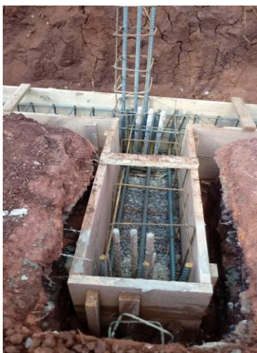
Figura 04: As armações executadas e posicionadas nas fôrmas na obra 01.
