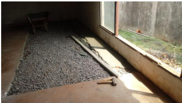
Figura 11: Preparo do piso para aplicação de revestimento acompanhado na obra 01.
