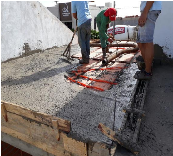
Figura 06: Concretagem por bombeamento acompanhada na obra 02.
