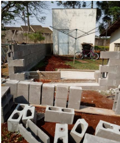
Figura 08: Assentamento de tijolos acompanhado na obra 01.
