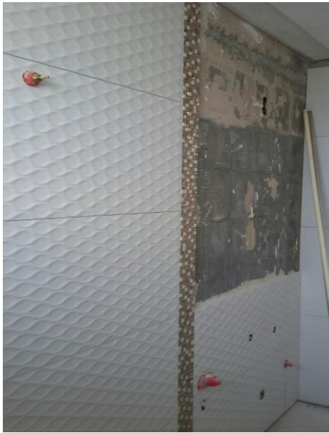
Figura 10: Aplicação de revestimento acompanhada na obra 02.
