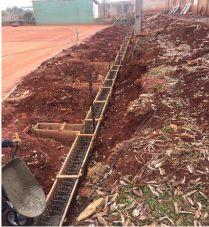
Figura 02: As fôrmas feitas na obra 01.
