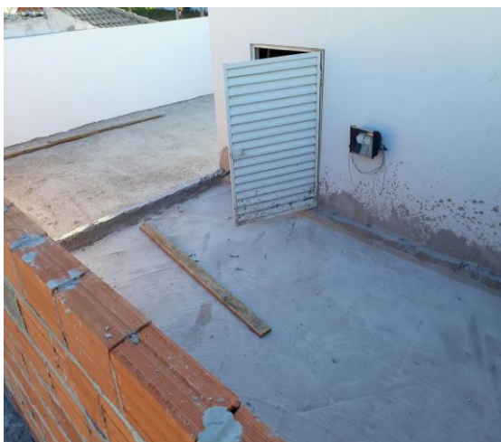
Figura 07: O processo de cura do concreto acompanhado na obra 02.
