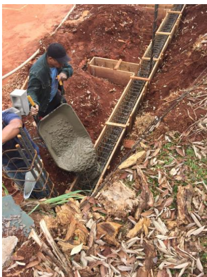
Figura 05: Execução de concretagem manual na obra 01.
