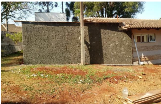
Figura 09: Preparo da parede para receber aplicação de revestimento na obra 01.
