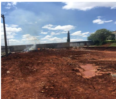
Figura 01: Terraplanagem acompanhada na obra 01.
