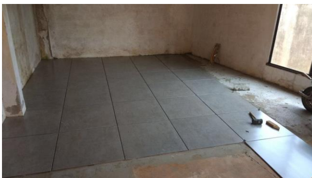
Figura 12: Aplicação de revestimento no piso, acompanhada na obra 01.
