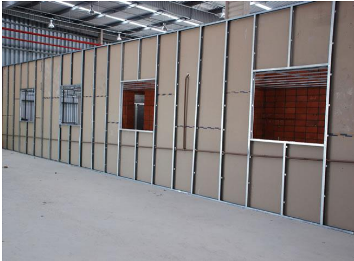
Figura 3- Execução de Drywall
