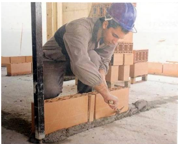
Figura 2- Execução da alvenaria
