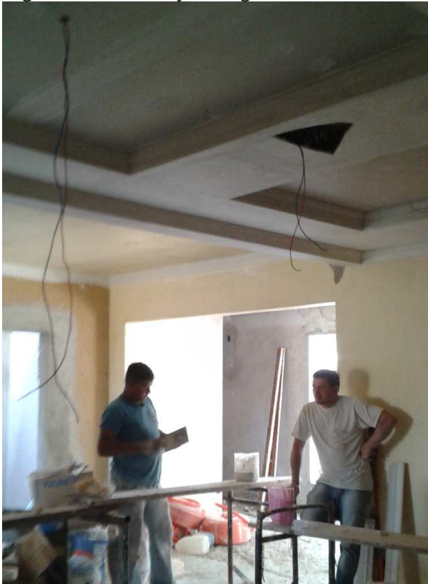
Figura 11 – Instalação do gesso
