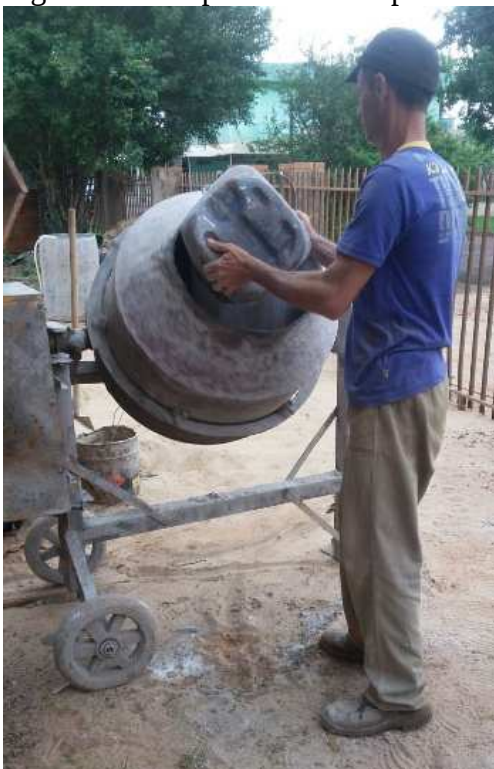
Figura 03 – Preparo da massa para o reboco
