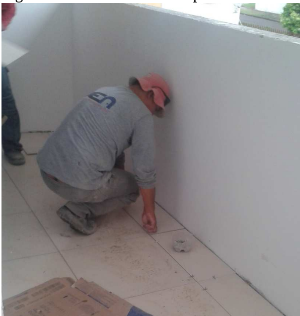
Figura 06 – Assentamento do piso
