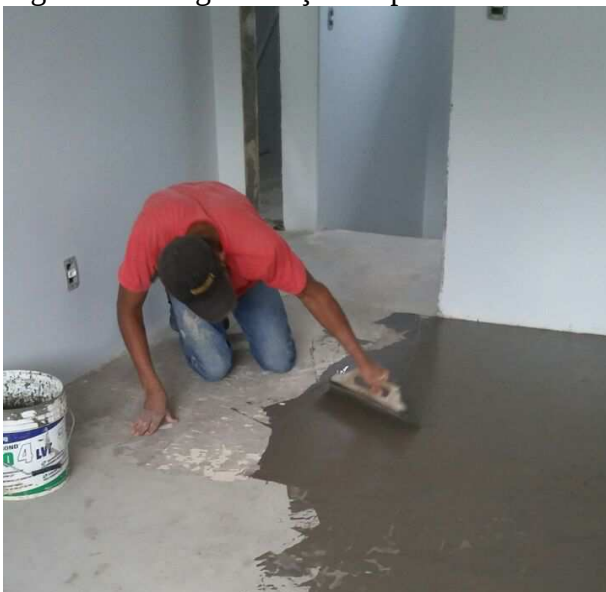
Figura 07 – Regularização do piso
