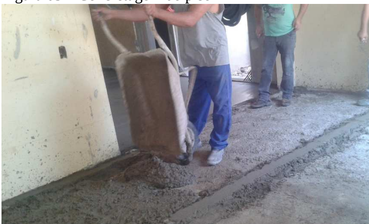
Figura 05 – Concretagem do piso
