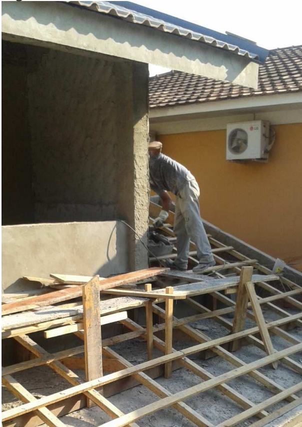
Figura 09 – Madeiramento do telhado
