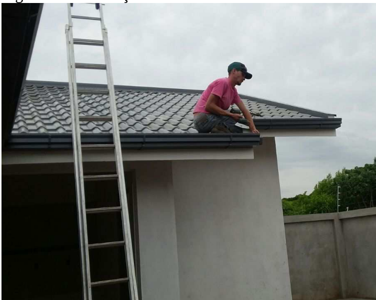
Figura 12 – Instalação de calha
