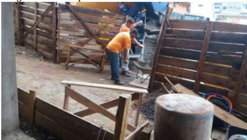
Imagem 09 – Transporte do Concreto até o local
