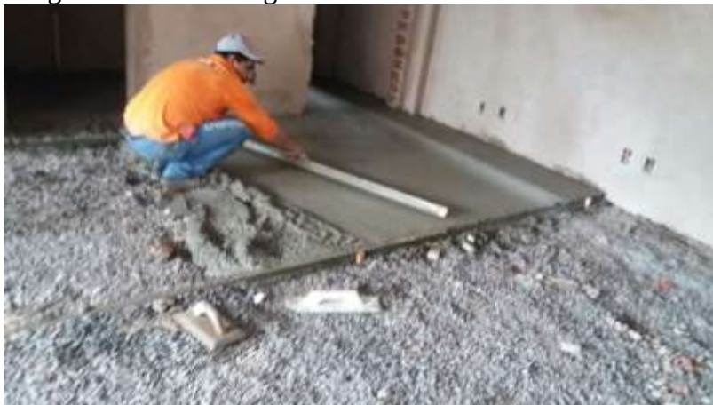
Imagem 10 – Concretagem do Piso
