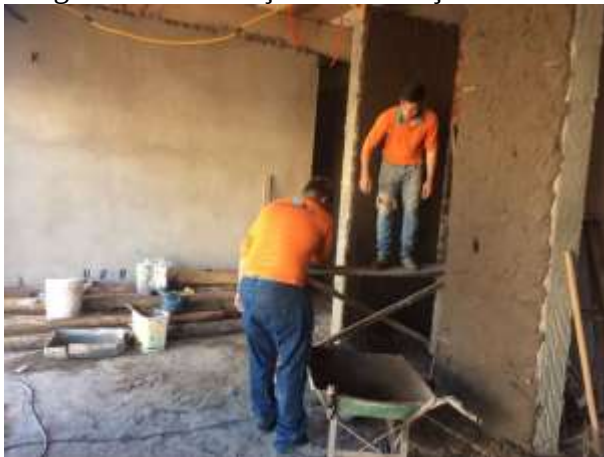
Imagem 03 – Execução do Emboço
