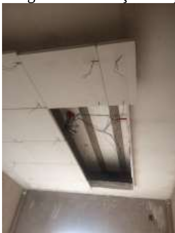
Imagem 12 – Fixação das placas de gesso
