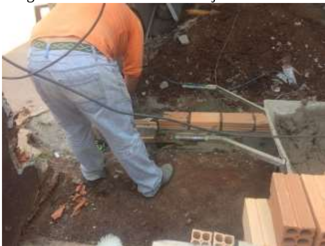
Imagem 01 – Assentamento de tijolo
