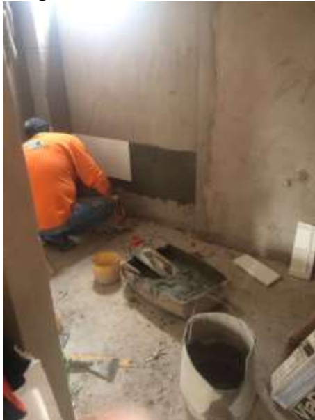
Imagem 07 – Assentamento de Revestimento Cerâmico na Parede
