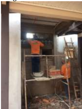
Imagem 14 – Assentamento dos Tijolos de Vidro
