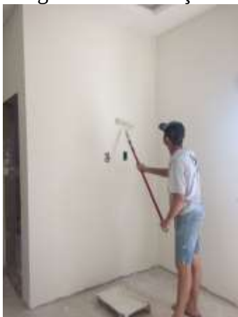
Imagem 16 – Execução da pintura.
