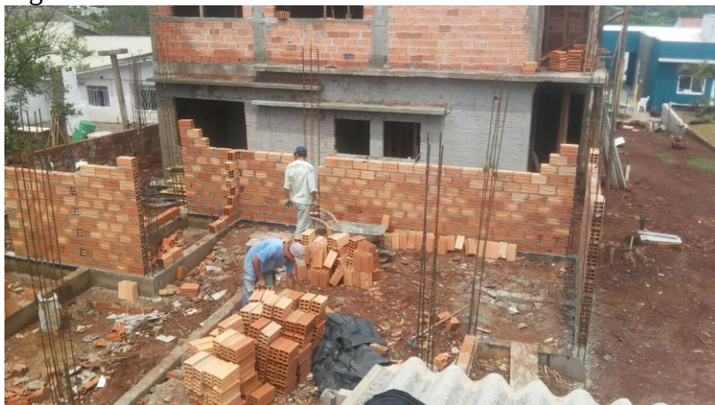
Figura 06: Assentamento da alvenaria do sobrado 04.
