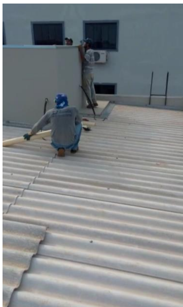
Figura 15: Instalação do rufo e calhas do sobrado 01.
