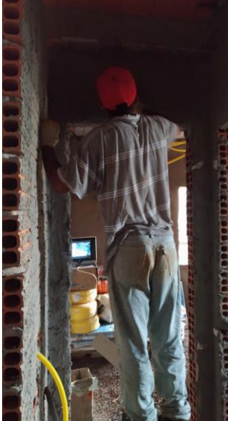
Figura 16: Aplicação do emboço, massa grossa, na parede.
