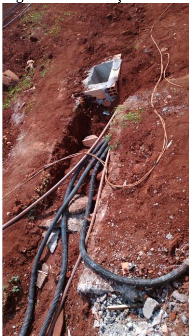
Figura 13: Tubulação elétrica subterrânea.
