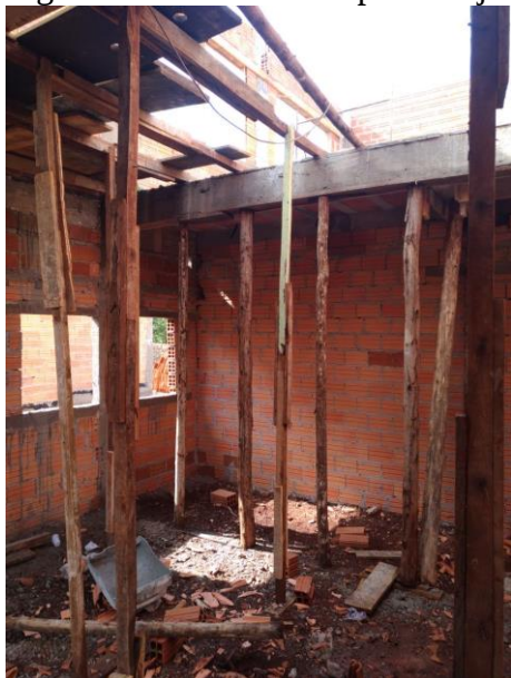
Figura 07: Escoramento para a laje do sobrado 03.
