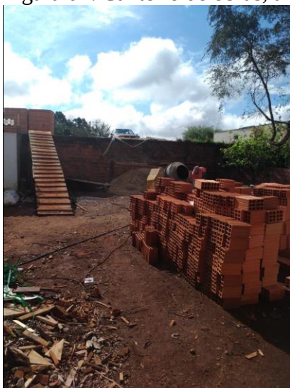
Figura 01: Canteiro de obras, armazenagem dos materiais não perecíveis.
