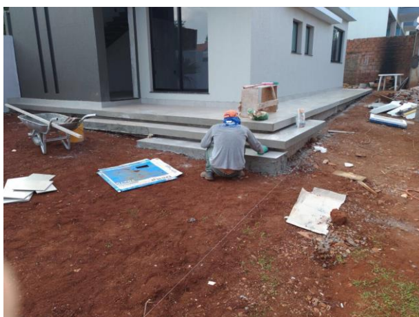
Figura 14: Assentamento de cerâmica da calçada do sobrado 01.
