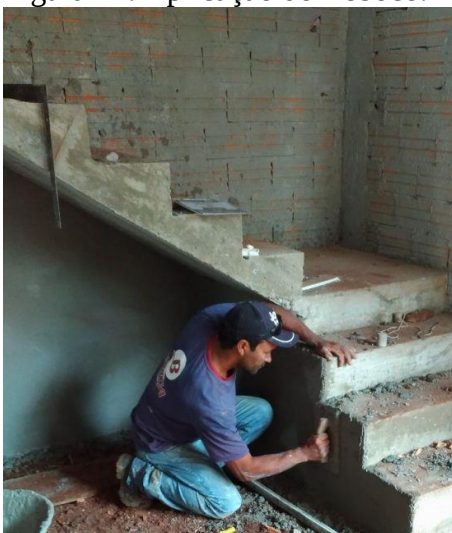
Figura 17: Aplicação do Reboco.
