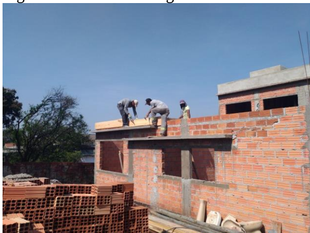
Figura 08: Formas das vigas do sobrado 03.
