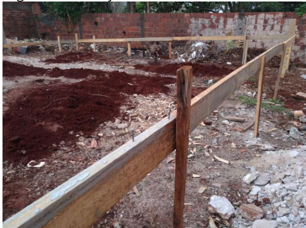
Figura 03: Locação da obra, sobrado 04.
