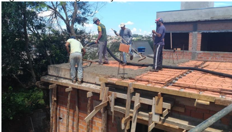
Figura 09: Concretagem da laje do sobrado 04.
