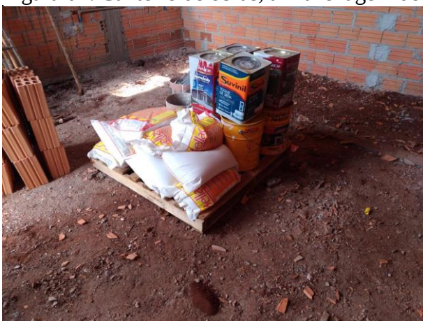
Figura 02: Canteiro de obras, armazenagem dos materiais perecíveis.
