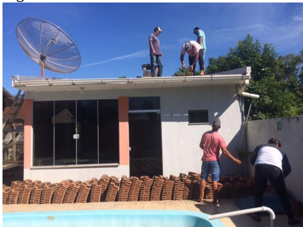
Figura 8 – Trabalhadores retirando as telhas da cobertura
