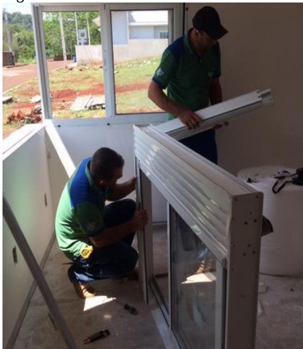
Figura 12 – Trabalhadores realizando os acabamentos finais para montagem da janela
