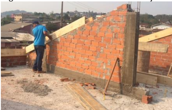
Figura 6 – Trabalhador fazendo a colocação da fôrma sobre a parede de alvenaria
