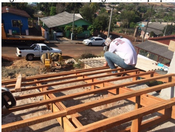
Figura 7 – Trabalhador pregando as terças para juntar as tesouras
