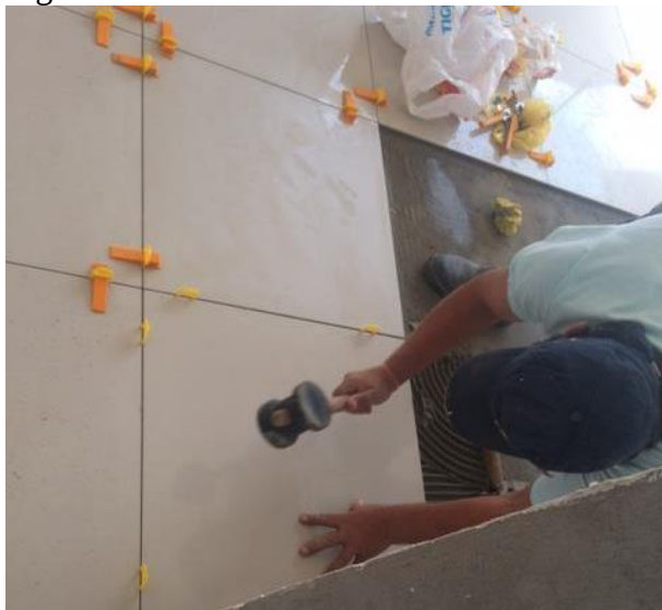
Figura 11 – Trabalhador utilizando o martelo de borracha
