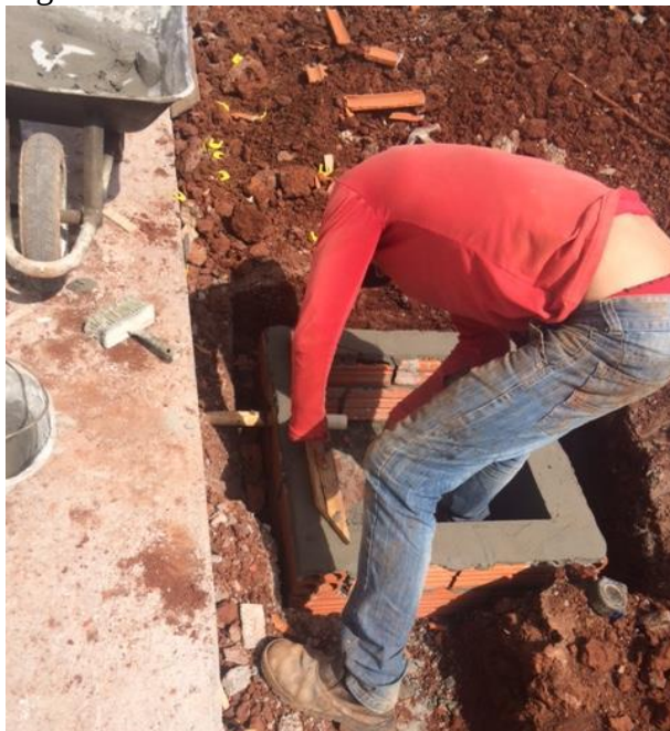
Figura 13 – Trabalhador construindo a caixa de gordura
