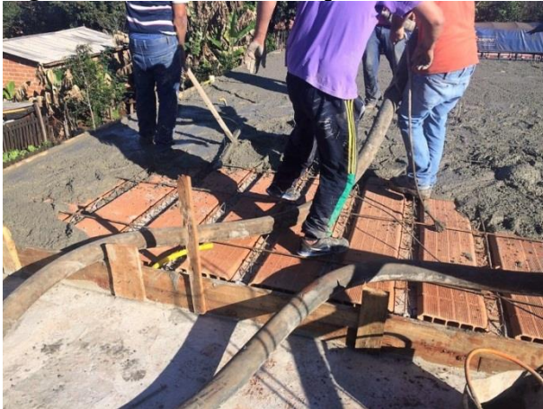
Figura 5 – Trabalhadores espalhando o concreto sobre a laje
