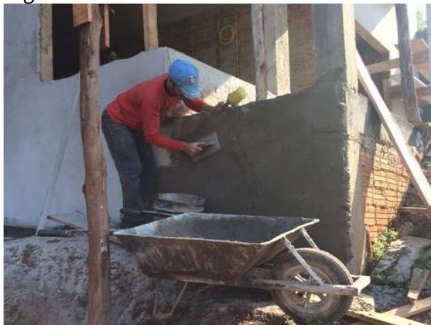
Figura 10 – Trabalhador fazendo o acabamento do reboco com a desempenadeira
