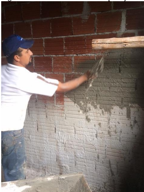
Figura 9 – Trabalhador fazendo a aplicação do chapisco sobre a parede
