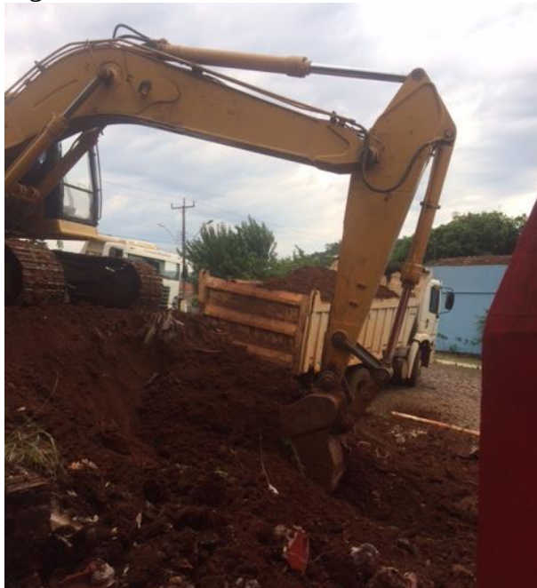
Figura 2 – Retroescavadeira retirando a terra e colocando na caçamba
