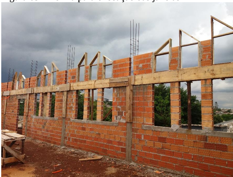
Figura 09 – Forma para execução das janelas
