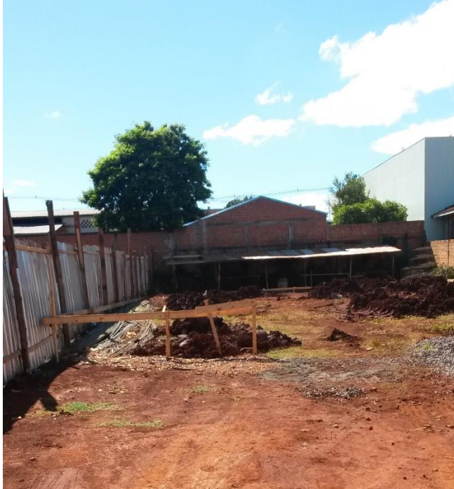
Figura 01 – Locação das estacas sobre o terreno
