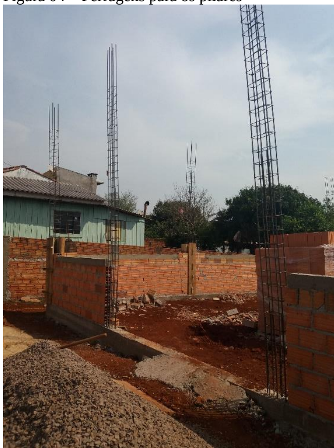
Figura 04 – Ferragens para os pilares
