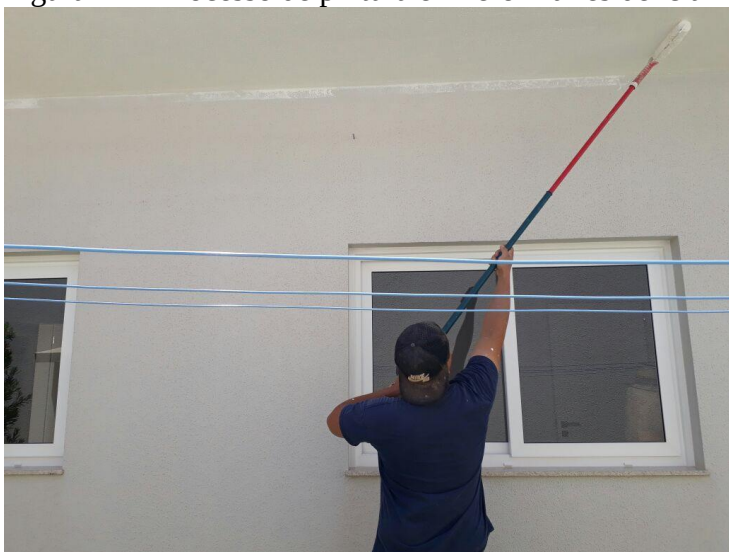
Figura 12 – Processo de pintura em reforma residencial
