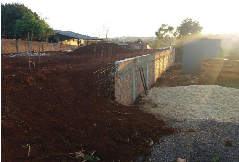
Figura 02 – Muro de contenção para aterro
