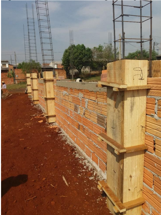
Figura 05 – Caixaaria e concretagem dos pilares
