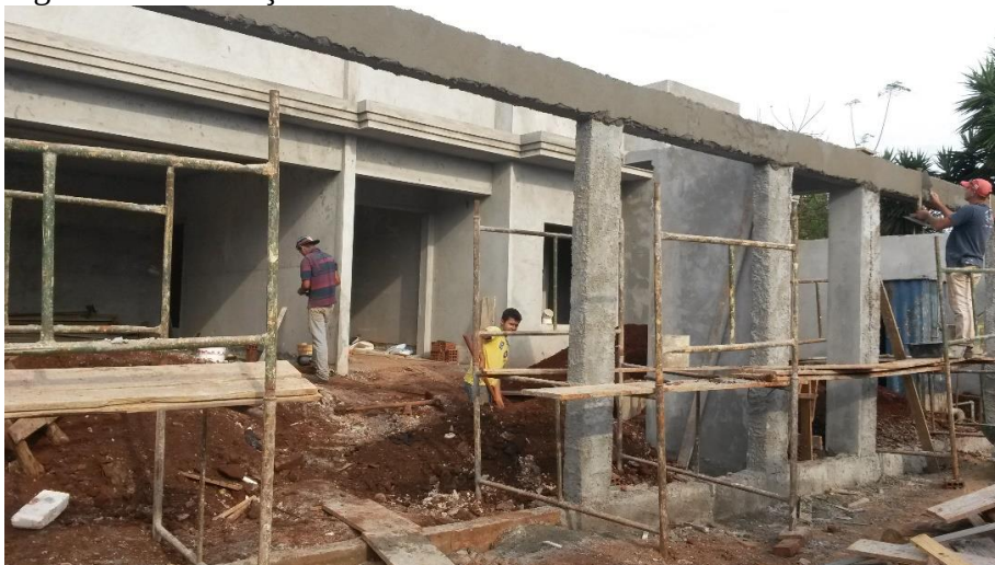
Figura 11 – Execução de reboco
