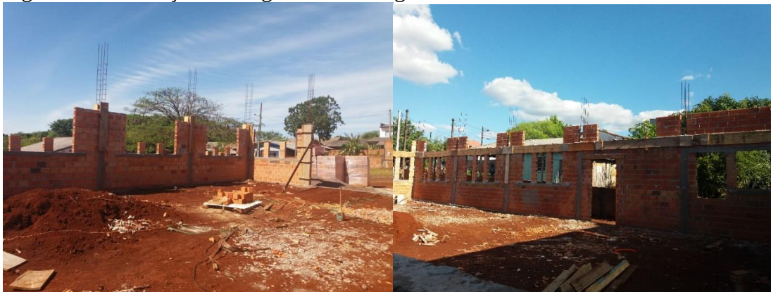
Figura 07 – Execução da verga e contra verga
