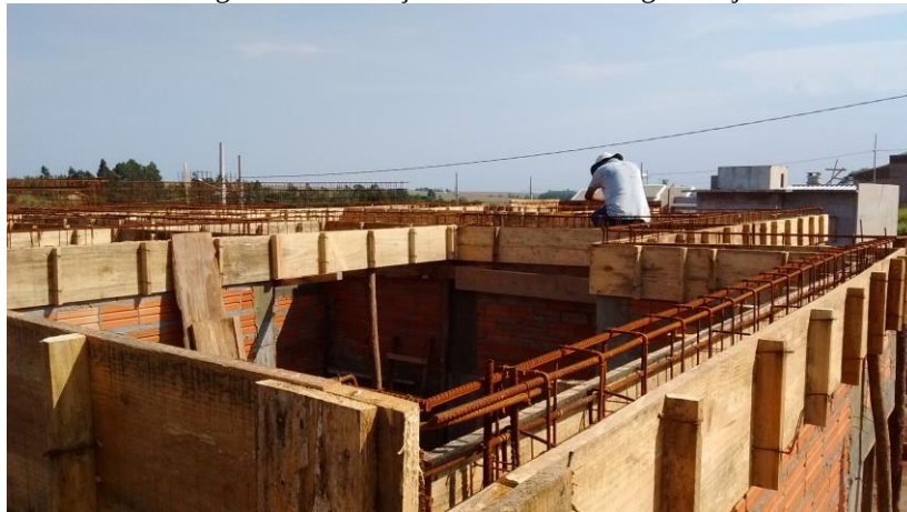
Imagem - 10 execução das formas da viga da laje
