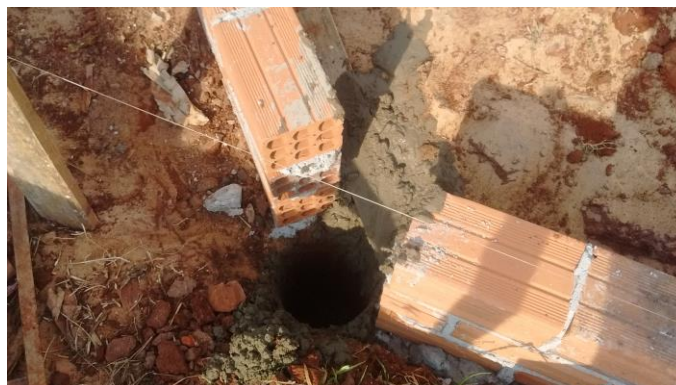
Imagem -02 Execução das estacs
