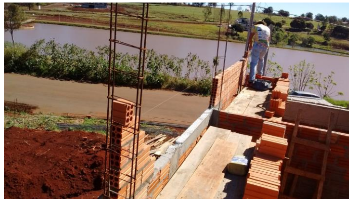
Imagem -03 Execução da alvenaria, blocos cerâmicos
