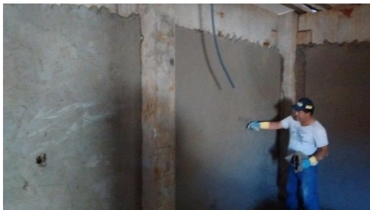
Imagem -07 Execução do revestimento em parede - Reboco
