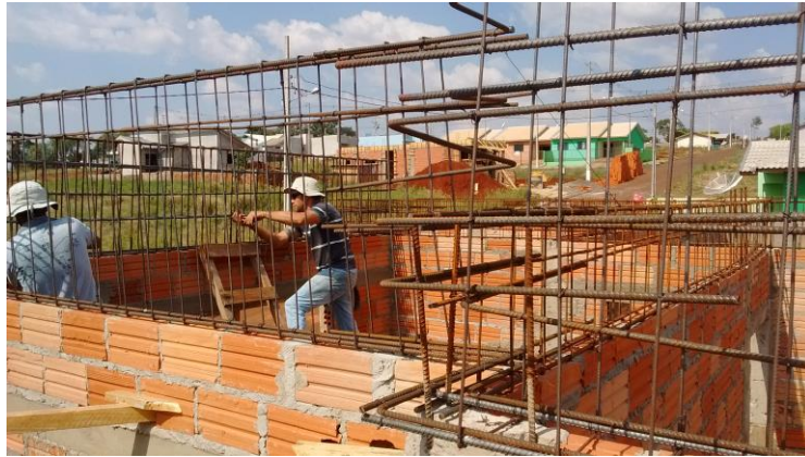
Imagem - 11 Execução das armaduras da viga da laje
