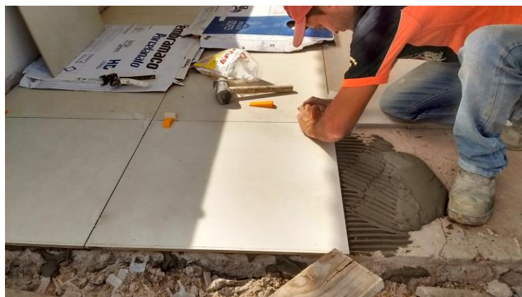
Imagem -09 Execução Piso Cerâmico
