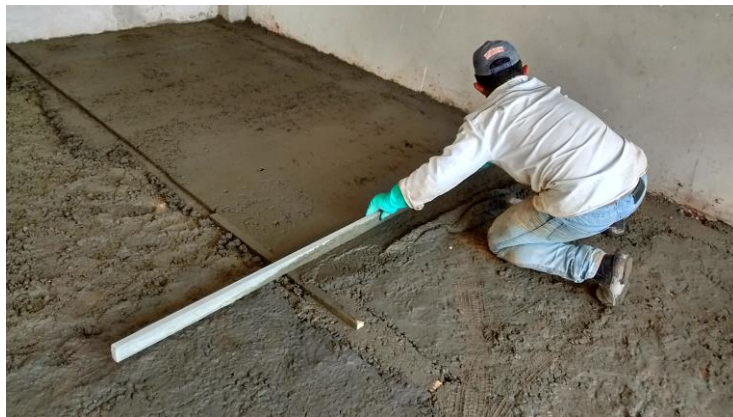
Imagem -08 Execução do Contra Piso
