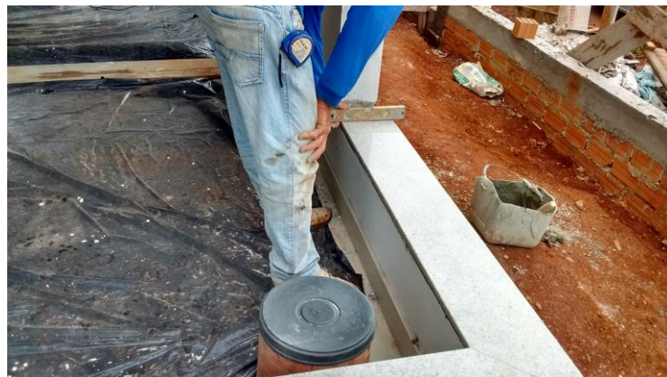
Imagem - 12 Assentamento da soleira de granito peitoril da Janela
