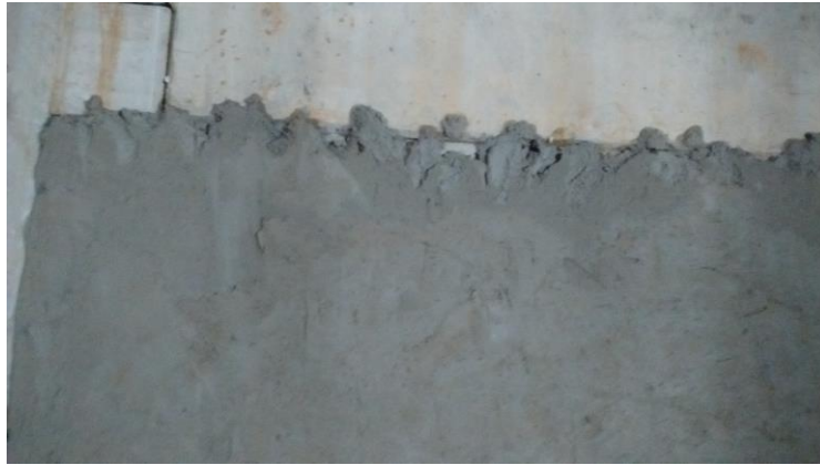
Imagem -06 Execução do revestimento em parede - Emboço
