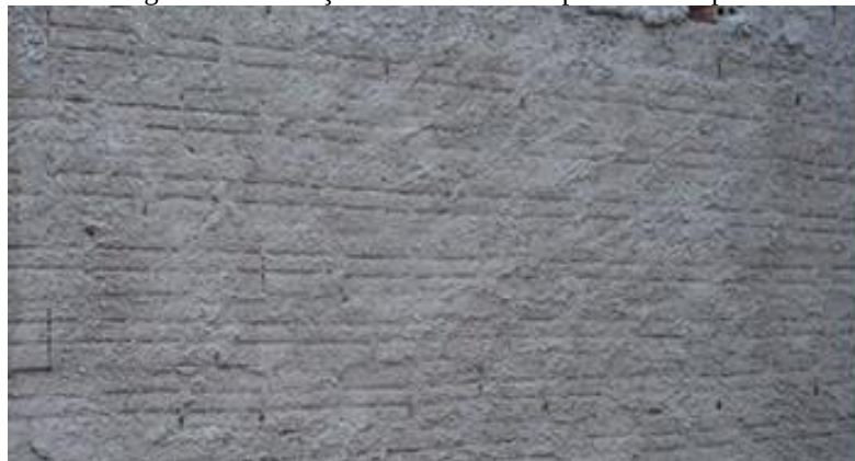
Imagem -05 Execução de revestimento parede - Chapisco
