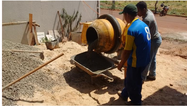
Imagem -04 Preparação da Argamassa
