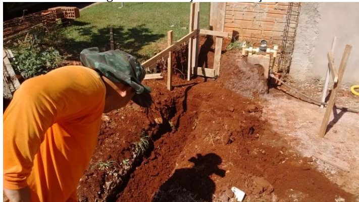
Imagem -01 Execução de fundações
