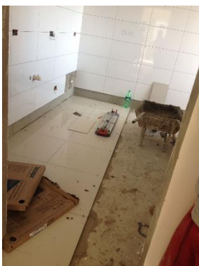
Figura 08. Assentamento de Porcelanato.
