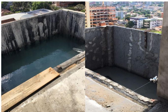
Figura 05. Tela aplicada na manta.
