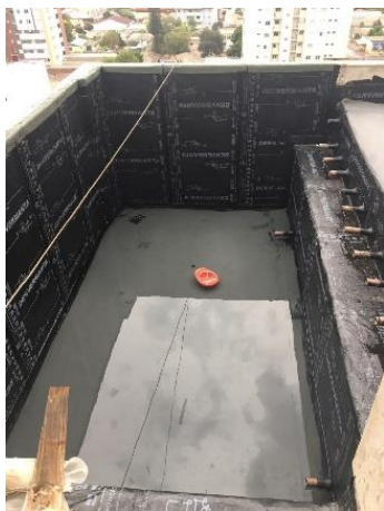
Figura 04. Malta asfáltica e dreno na piscina.
