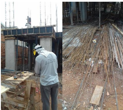
Figura 02. Montagem da armadura para concreto.
