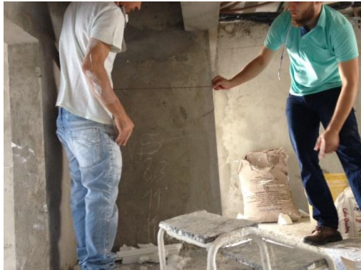
Figura 20. Marcação da parede para colocação do gesso.
