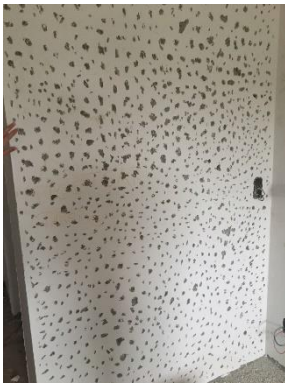
Figura 11. Parede picotada para receber revestimento.
