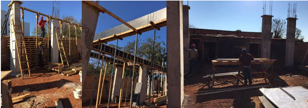
Figura 07. Montagem de forma viga.
