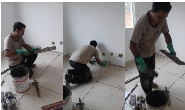
Figura 12. Assentamento de rodapé.
