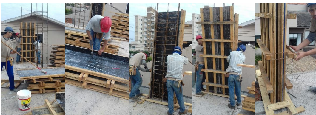
Figura 06. Montagem de forma de pilar.
