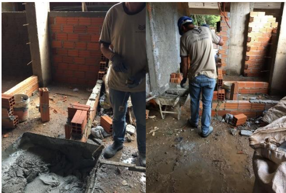
Figura 22. Assentamento de Alvenaria.
