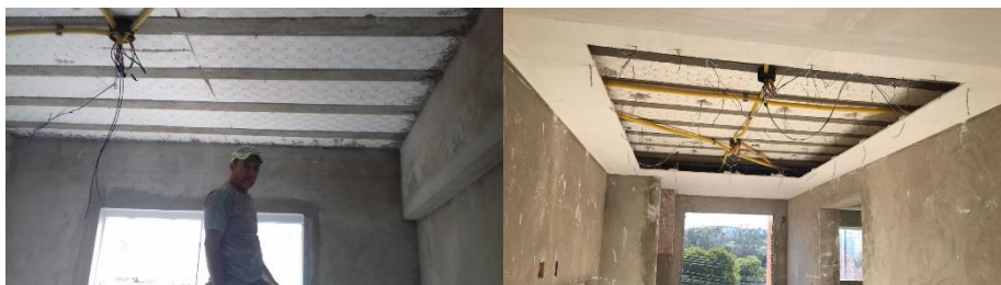
Figura 18. Instalação do Gesso.
