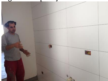
Figura 10. Aplicação de Revestimento na Parede.
