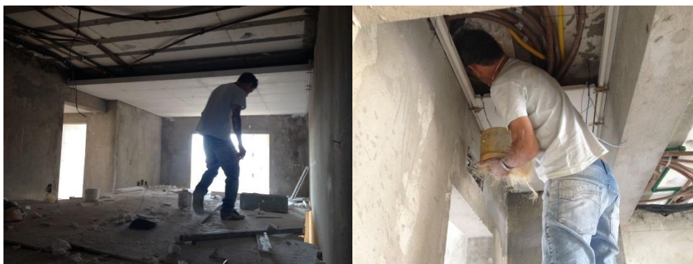
Figura 21. Instalação das placas de gesso.
