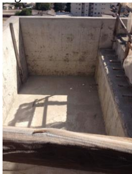
Figura 03. Arredondamento dos cantos da piscina.
