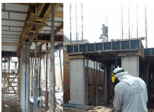
Figura 17. Escoramento da laje.
