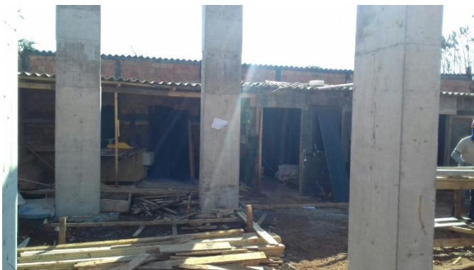
Figura 23. Canteiro de Obra.
