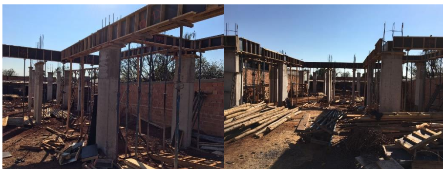
Figura 17. Escoramento de vigas.
