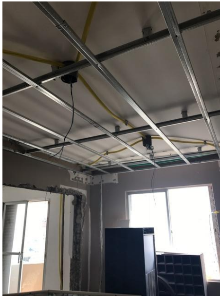
Figura 1: Instalação forro de gesso
