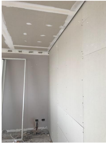
Figura 3: Finalização de forro e divisória de gesso
