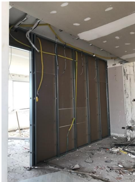
Figura 2: Instalação de divisória em Drywall
