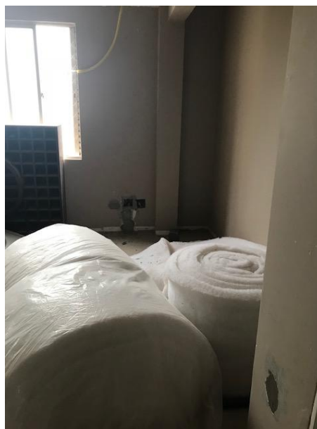
Figura 4: Recebimento de mantas de lã de vidro
