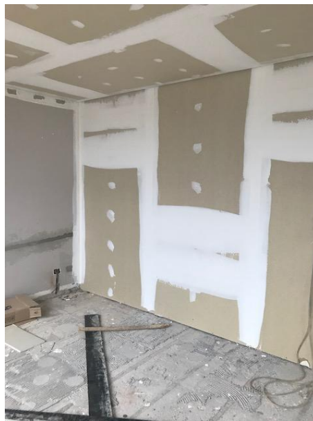
Figura 6: Finalização de forro e parede em gesso acartonado
