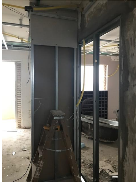
Figura 5: Instalação de parede em Drywall
